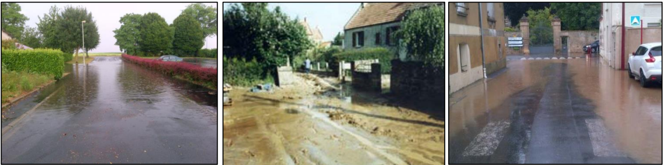
Photographie 2 : Inondations de voiries et de prairies au cours d'épisodes orageux à Cresserons et Plumetot (source : EGIS, 2015)
