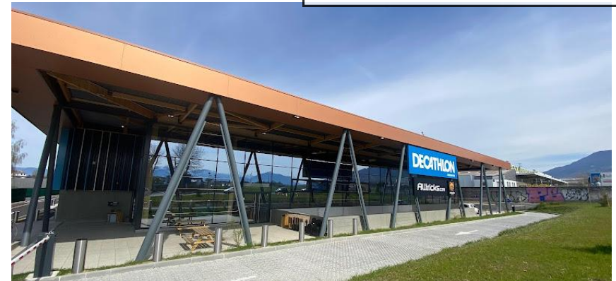
Le nouveau magasin Decathlon Annemasse
