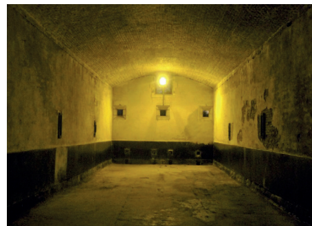
Fort de Châtillon le Duc, magasin à poudre Source : AUDAB 2019
