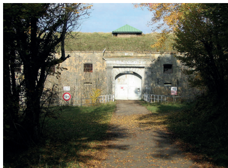
Fort Woïrol à Montfaucon Source : Xofc - 2011
