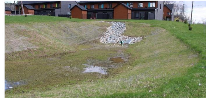
Exemples de dispositif de stockage et d'infiltration diffus
