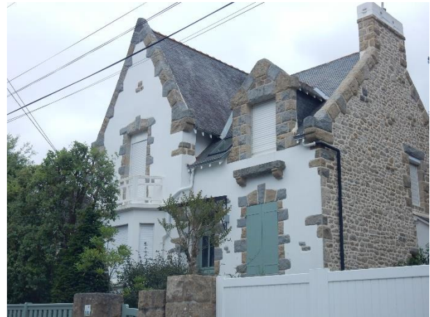
L'enduit blanc participe à la mise en valeur de l'architecture néobrettonne structurée par les encadrements de granit apparent
