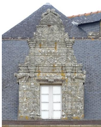
Kermalvezin Lucarne passante de villa à deux pans
