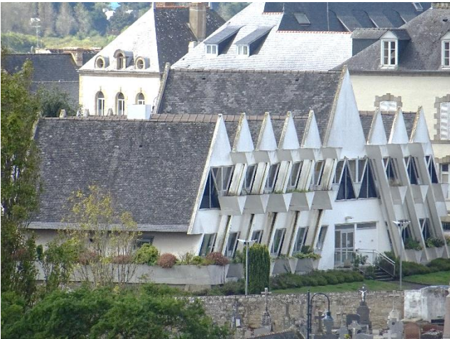
Mairie de Carnac. Pierre-Alexis Kobakhidzé, architecte, 1973-1975.
