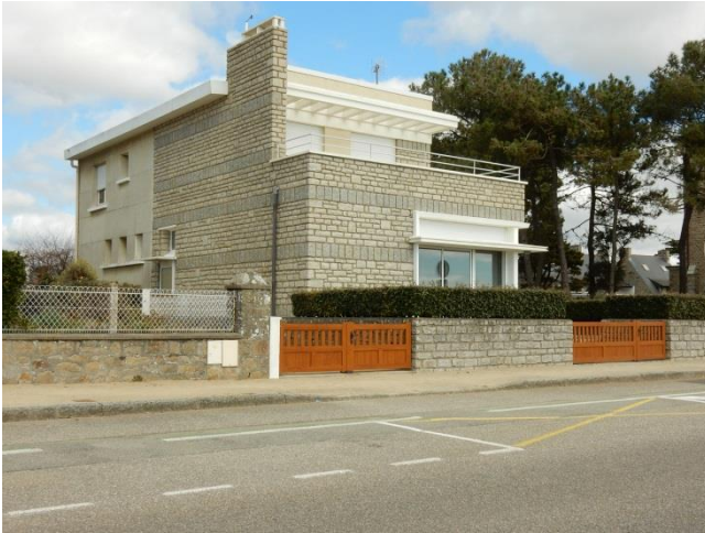
Villa Maury, 34, boulevard de la Plage. 1948. Quémard et Méliès, architectes.
