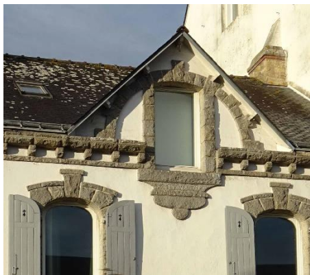
Rue Saint-Cornély Lucarne à fronton en faux pignon
