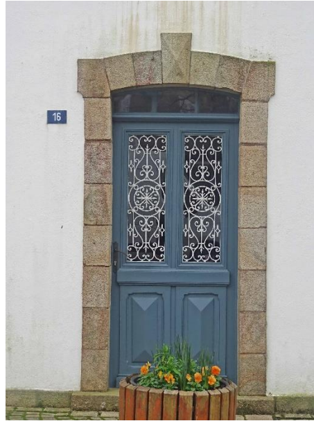
Place de l'église Porte à panneaux et jour avec grille en fonte ou serrurerie
