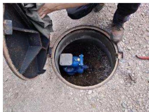
Figure 5 : Exemples d'un regard sous chemin et intérieur d'un regard à ventouse
