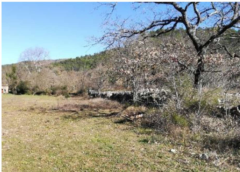
Figure 9: Merlons présents en rive droite de la Nartuby, à l'aval de la confluence du Bivosque
