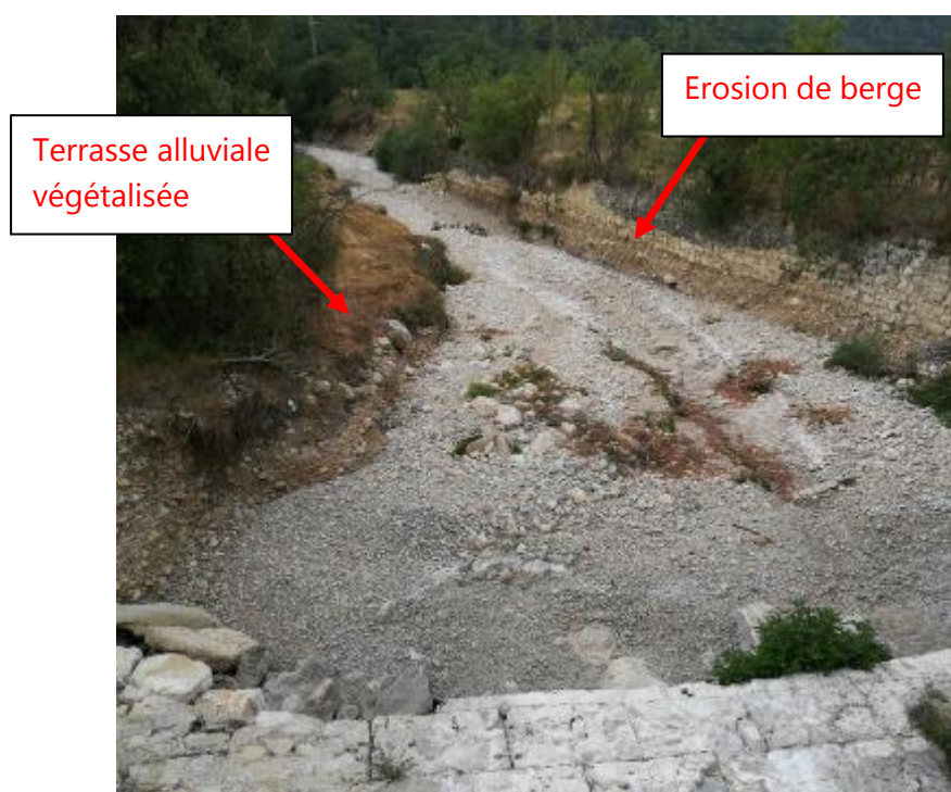
Figure 23: Zone aval du pont de la RD 51
