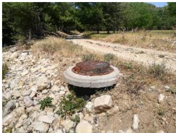
Figure 24: Réseau d'eau usée mis à nu
