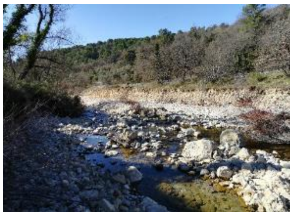
Figure 11: Erosion en rive droite à l'aval de la confluence avec Baume Garnier
