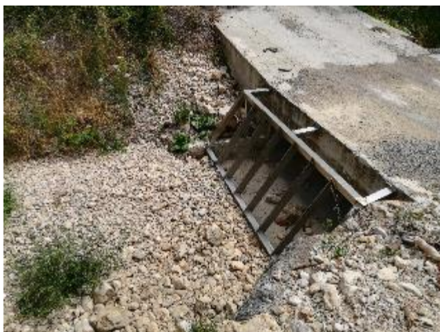
Figure 7 : Grille en amont du cadre béton
