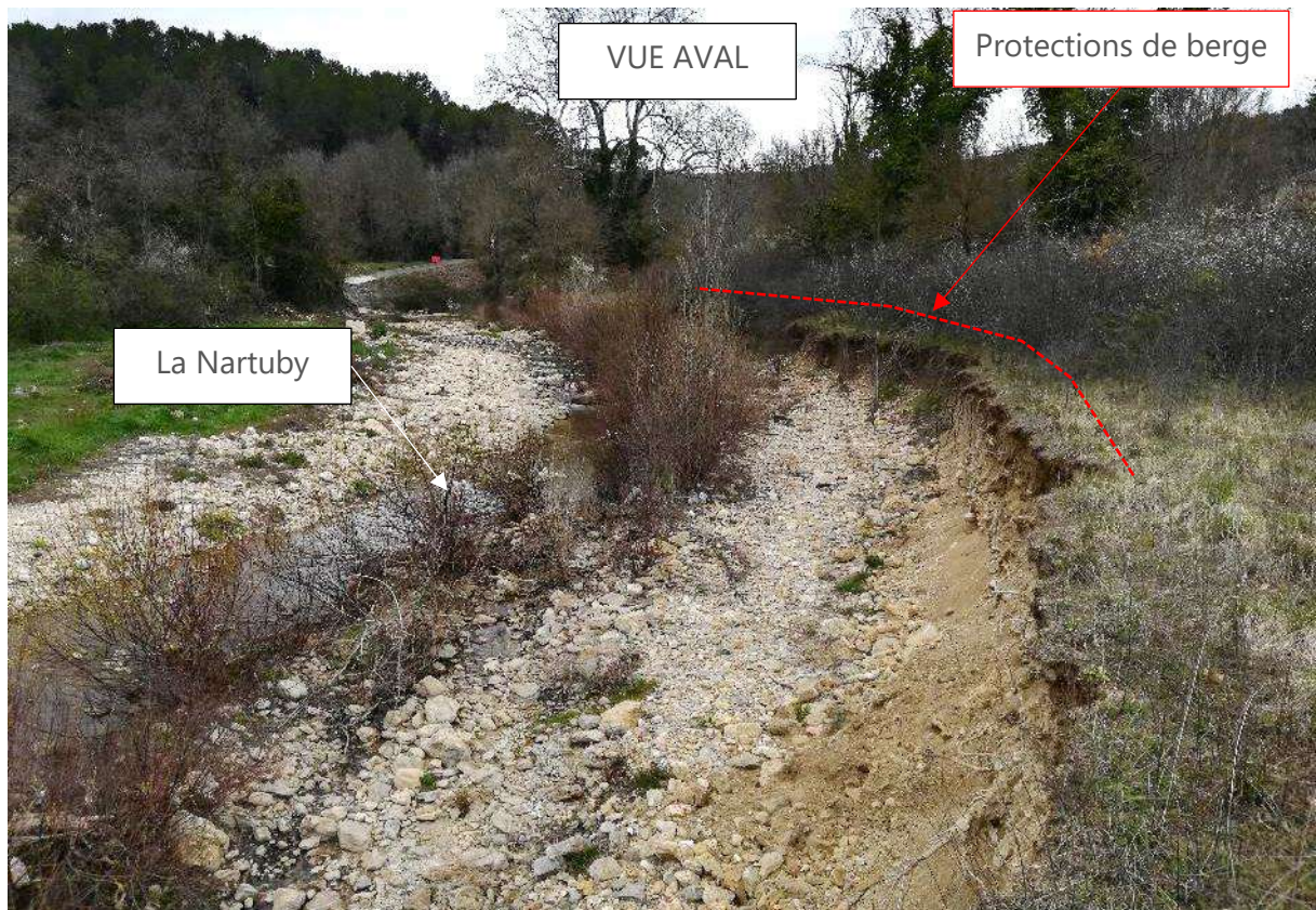
Figure 9 : AM3 – Vues amont et aval
