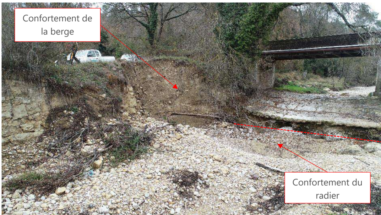
Figure 34 : AM18 – Vues aval
