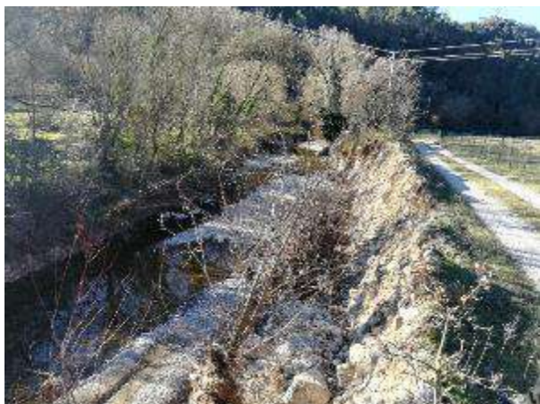
Figure 65: Zone d'érosion en bordure de piste d'accès
