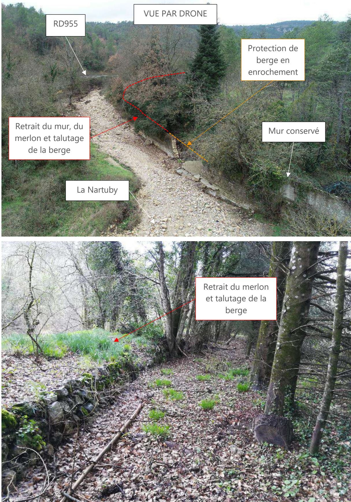
Figure 22 : AM10 – Vues par drone et depuis le lit majeur
