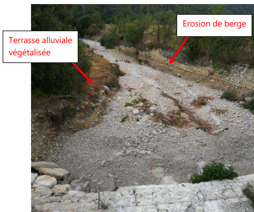
Figure 63: Zone aval du pont de la RD 51
