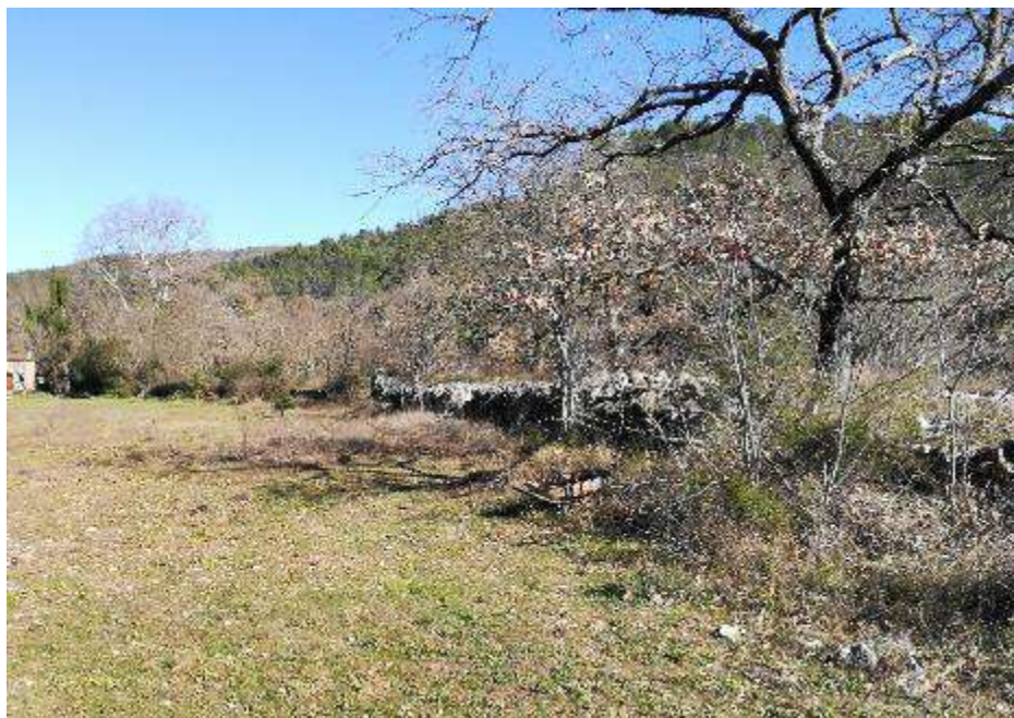
Figure 49: Merlons présents en rive droite de la Nartuby, à l'aval de la confluence du Bivosque
