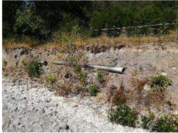
Figure 57: Anciens réseaux mis à nu
