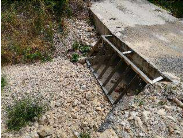
Figure 47 : Grille en amont du cadre béton
