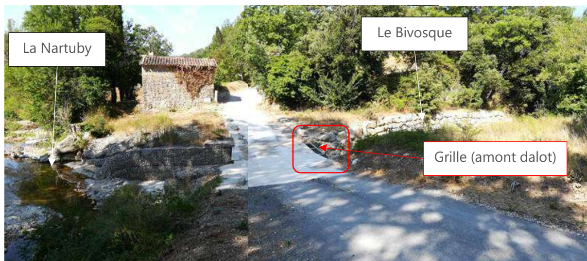
Figure 5 : AM1 – Vue de la grille depuis l'Est
