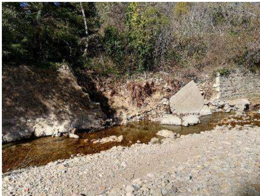
Figure 58: Mur de protection en rive droite sur le secteur de Pré Nouveau
