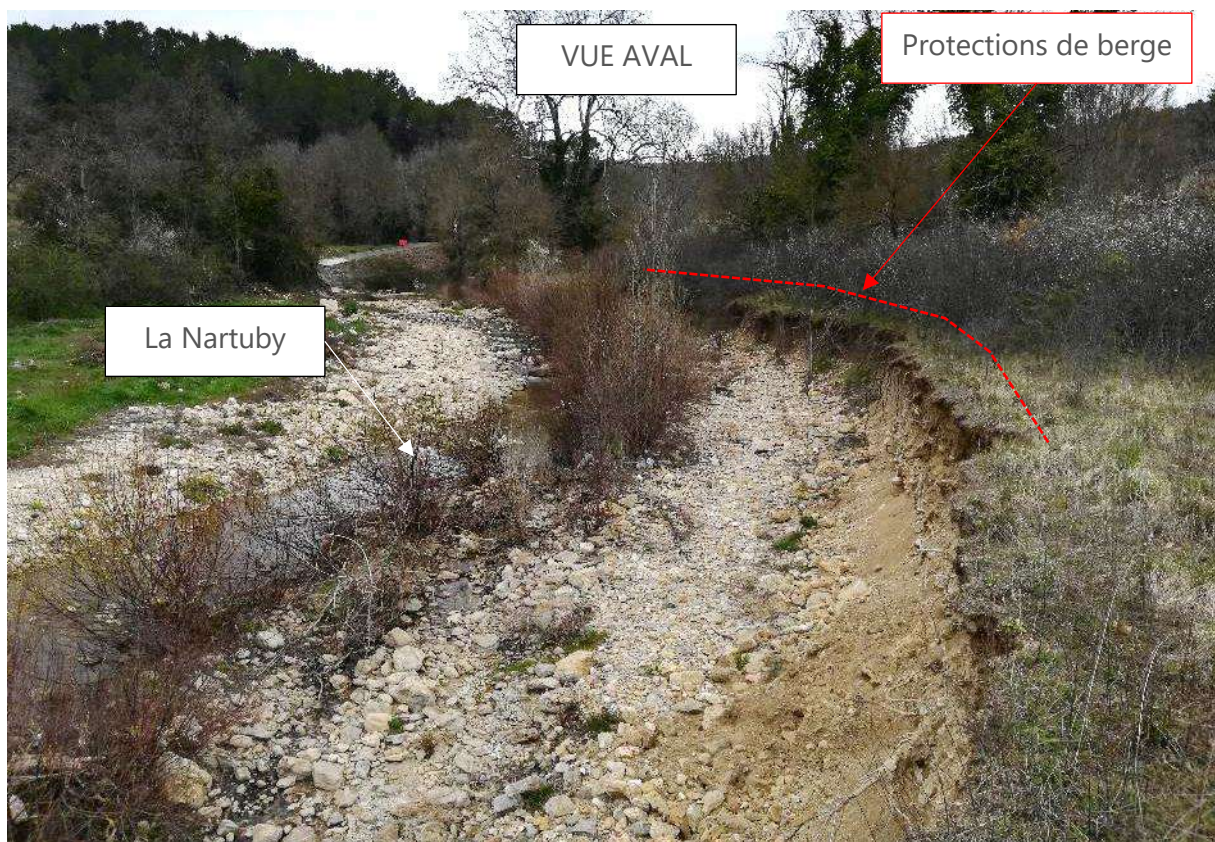
Figure 9 : AM3 – Vues amont et aval
