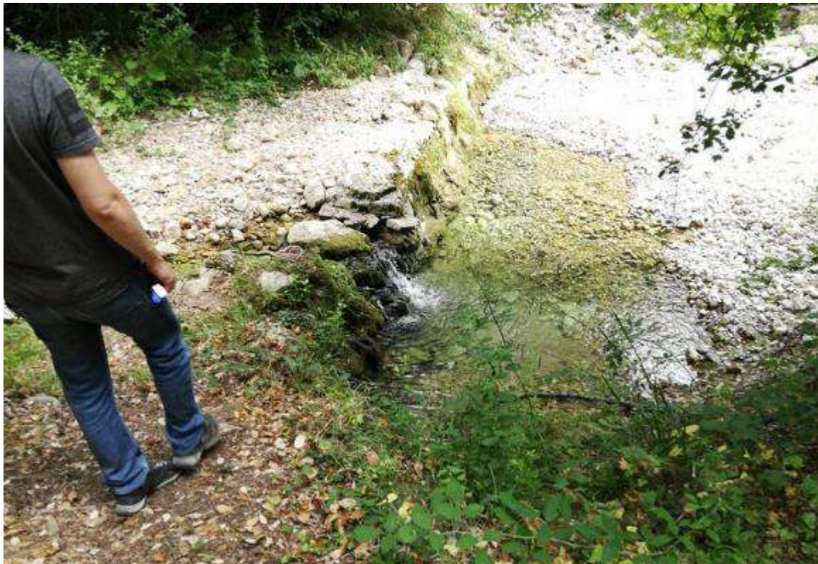
Figure 6 : Seuil sur le Bivosque à 300 m en amont de la confluence avec la Nartuby (2020)
