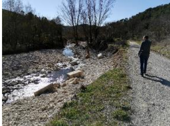
Figure 52: Route d'accès à la Tuilière
