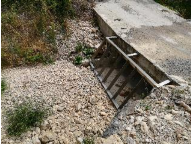
Figure 47 : Grille en amont du cadre béton
