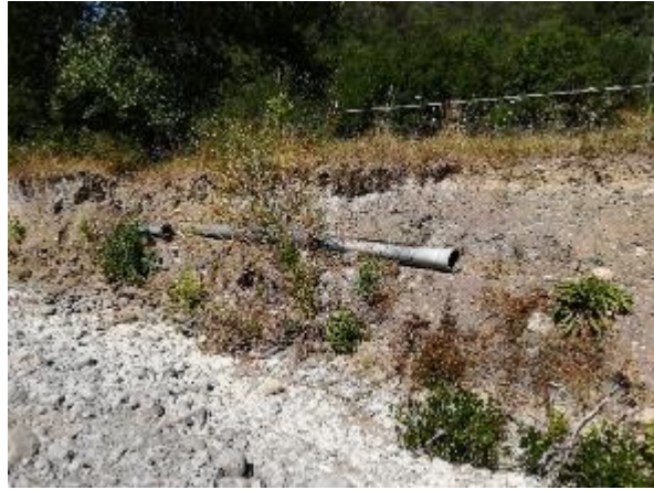
Figure 57: Anciens réseaux mis à nu
