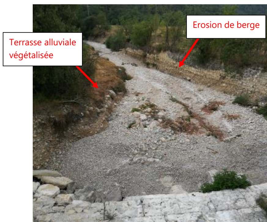
Figure 63: Zone aval du pont de la RD 51
