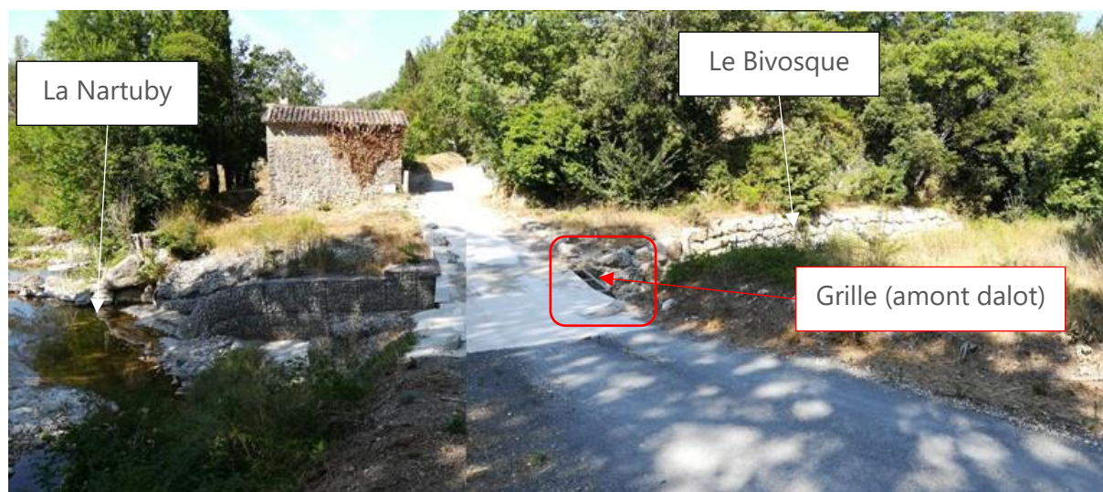
Figure 5 : AM1 – Vue de la grille depuis l'Est
