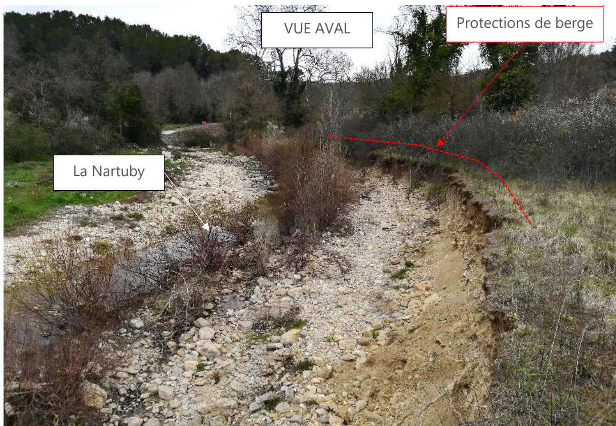
Figure 9 : AM3 – Vues amont et aval
