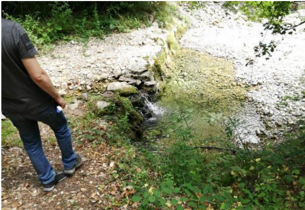
Figure 6 : Seuil sur le Bivosque à 300 m en amont de la confluence avec la Nartuby (2020)
