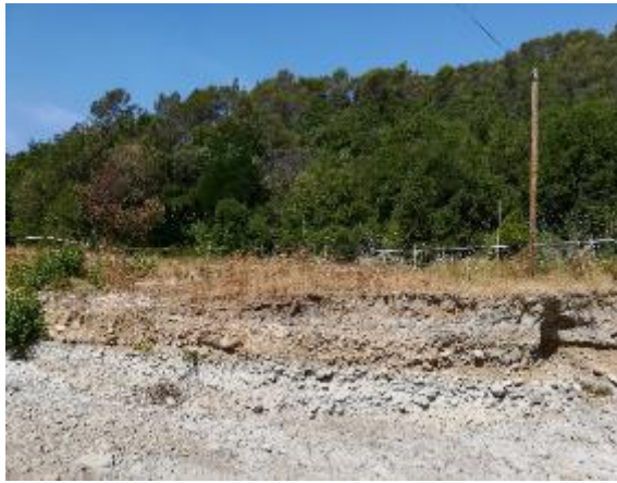
Figure 56: Poteau électrique menacé par l'érosion
