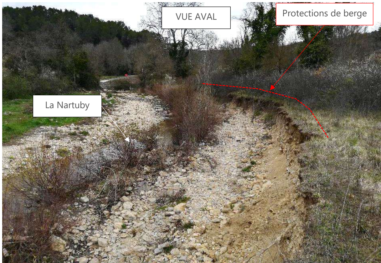
Figure 9 : AM3 – Vues amont et aval
