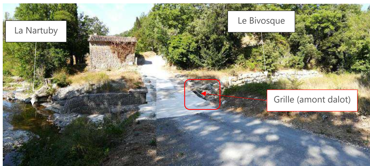
Figure 5 : AM1 – Vue de la grille depuis l'Est
