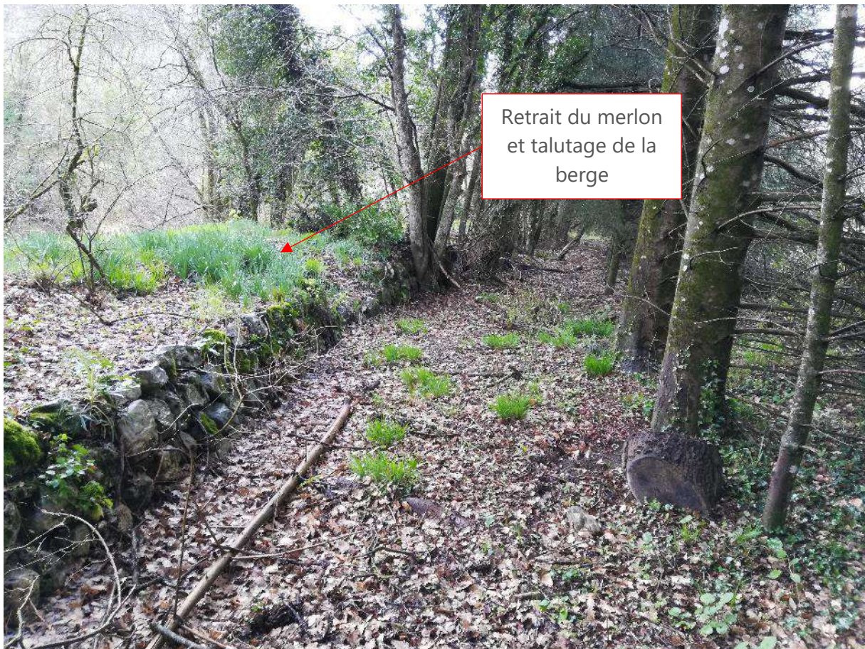
Figure 22 : AM10 – Vues par drone et depuis le lit majeur
