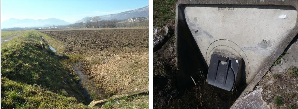
Contre canal (g) - Clapet anti-retour au niveau d'une buse traversant la digue (d)
