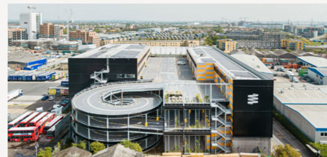
→ Barking Industria, Londres, Haworth Tomkins, village d'entreprises vertical avec cour de livraison en étages accessible aux véhicules par une rampe.
