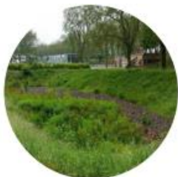
Ambiance des bassins de rétention
