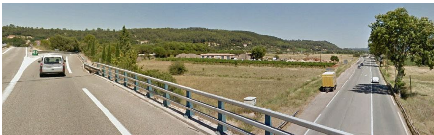
Vue 7 – Vue sur la partie Est du site et sur l'A8 en contrebas de l'A57
