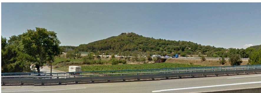
(3) Vue sur la partie Ouest du site depuis l'A57 // Source : CITADIA
