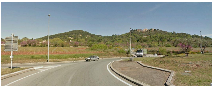
(4) Vue sur le Vieux-Cagnes en entrée de ville Est du Cagnes // Source : CITADIA
