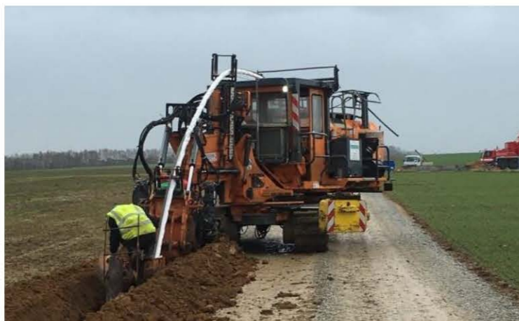
Photo 2 : mise en place du réseau électrique inter-éolien
