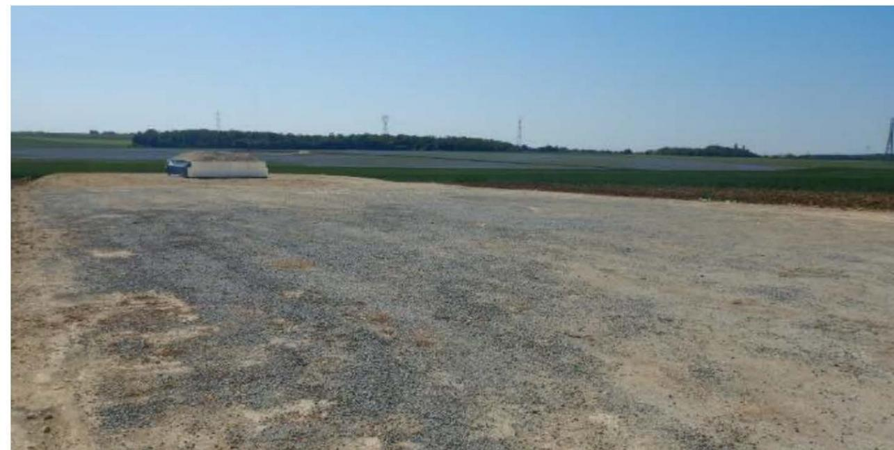
Photo 1 : plateforme de grutage en phase chantier (parc éolien de Bornay 2)
