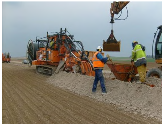
Figure 27 : Tranchée pour l'enfouissement des câbles électriques
