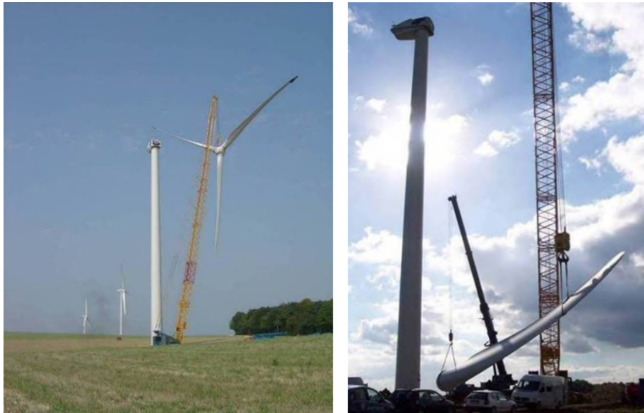
Figure 25 : Grue de montage et élevage du rotor
