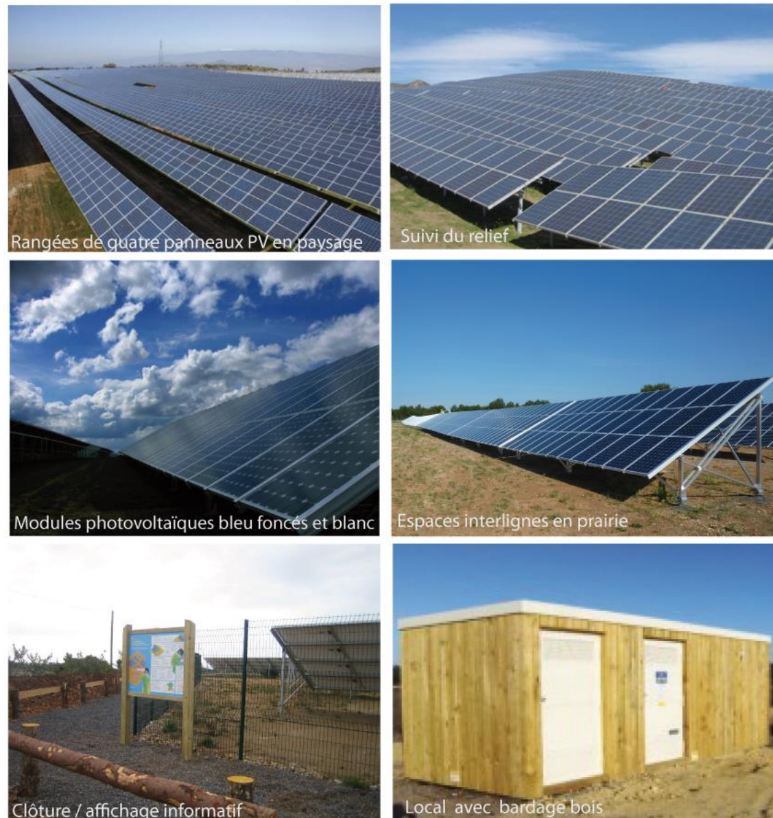
Photographie 54 : Exemples de centrales photovoltaïques au sol
