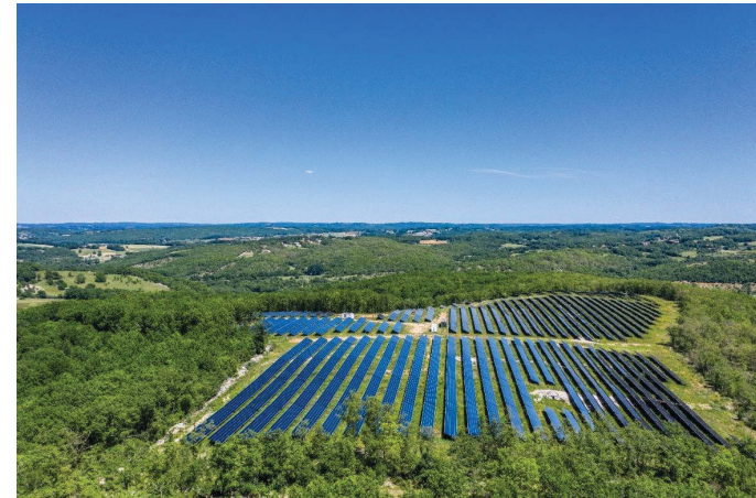
Centrale de Salviac (46) Localisation : Salviac (Lot) Surface totale : 11 ha Puissance : 4,5 MWc En service : décembre 2017 Activité agricole : exploitation ovine
