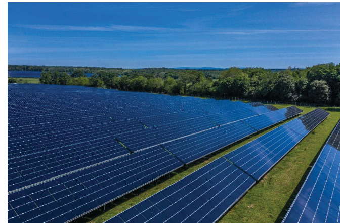
Centrale de Verneuil (58) Localisation : Verneuil et Charrin Surface totale : 70 ha Puissance : 43 MWc Mise en service : décembre 2017 Activité agricole : exploitation ovine
