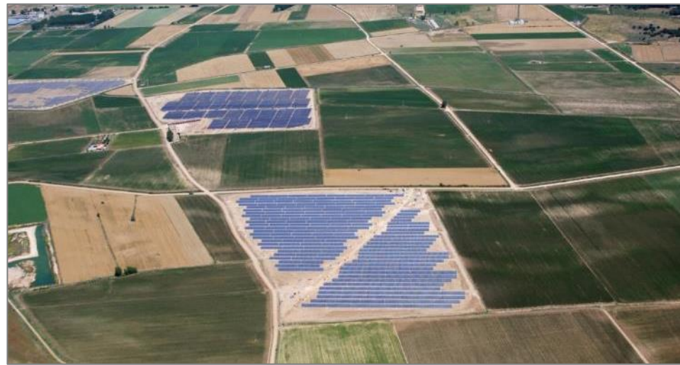
Photographie 47 : Illustration de la concurrence avec les terrains agricoles en Espagne (source : Imbert)
