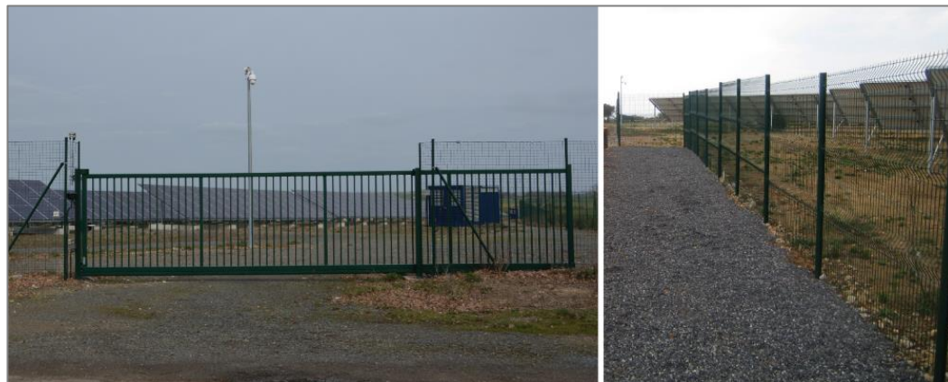
Figure 39 : Clôture de sécurité (Source : ENCIS Environnement)
