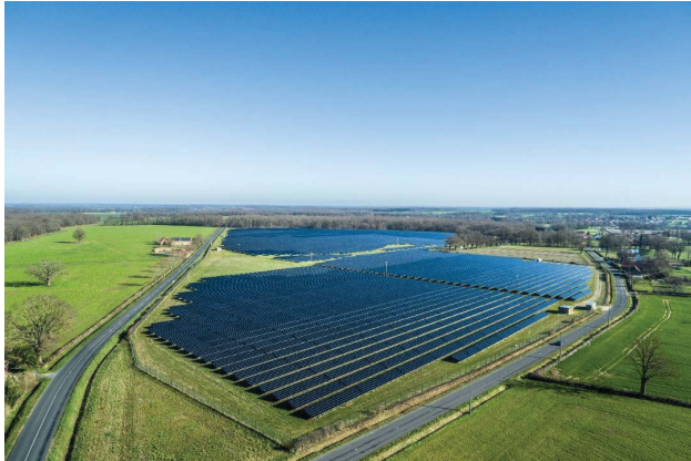
Centrale de Gennetines (03) Localisation : Gennetines (Allier) Surface totale : 20 ha Puissance : 12 MWc En service : février 2014 Activité agricole : exploitation ovine
