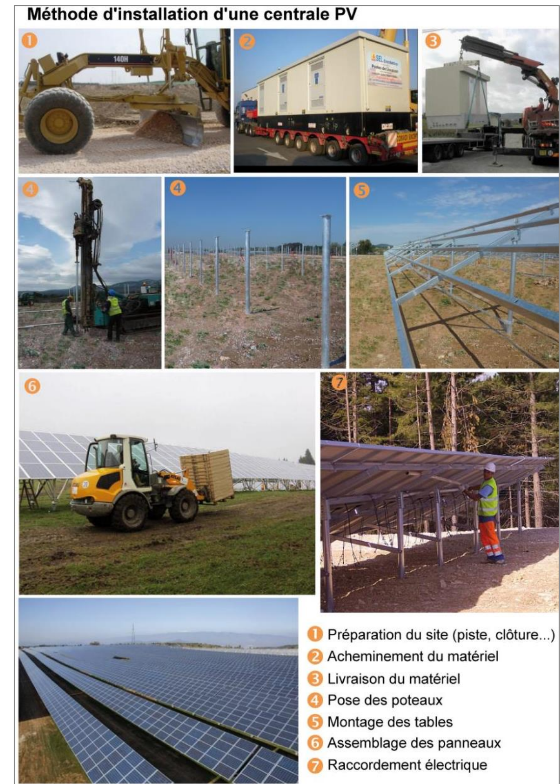
Photographie 45 : Construction d'une centrale photovoltaïque (Source : ENCIS Environnement)
