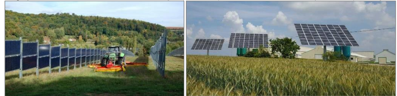
Photographie 2 : Parc photovoltaïque de Dirmingen (Source : Next2Sun) et exemple de panneaux « tournesol » en grande culture (Source : OKwind.fr)
