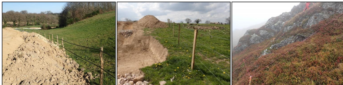
Figure 51 : Exemple de mise en défens de zone sensible en phase chantier (Source : Crexeco)
