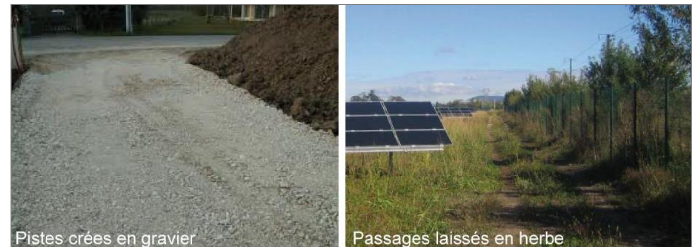
Photographie 44 : Pistes internes (Source : ENCIS Environnement)
