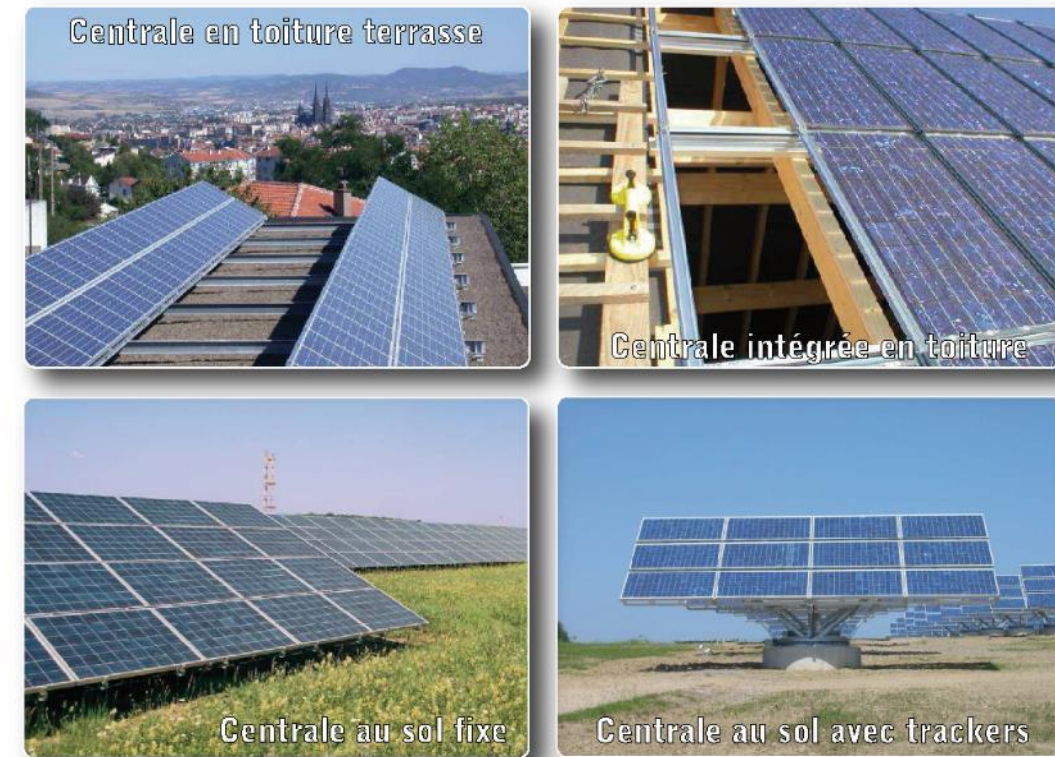
Figure 2 : Modes d'installations photovoltaïques (Source : ENCIS Environnement)
