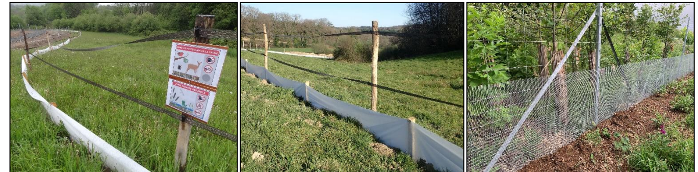
Figure 53 : Exemples de mise en défens associée à un système anti-intrusion (Source : Crexeco)
