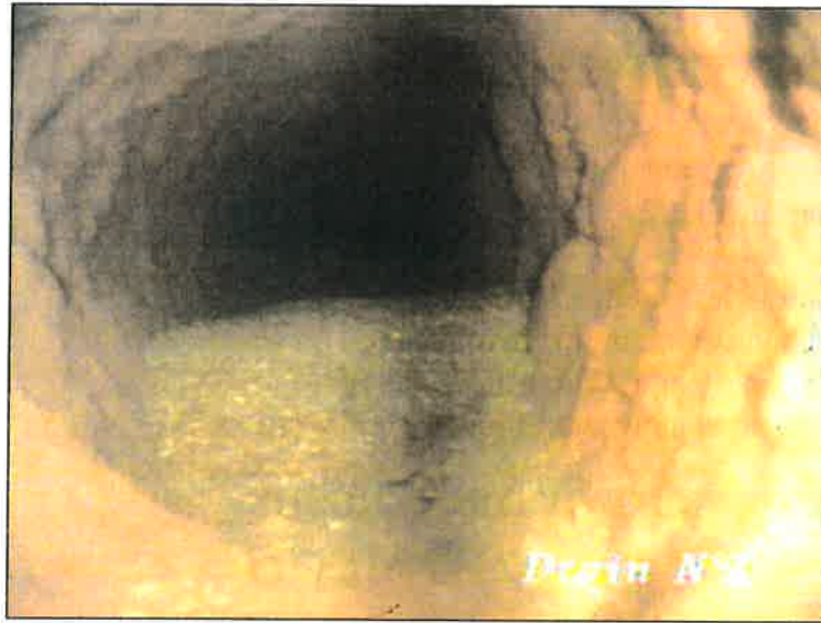
Fig. 7 – Photo tronçon 4 – colmatage et remplissage de sable
