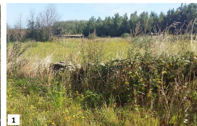
Ancien muret en pierre en limite de parcelle
