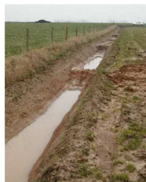
Schéma de principe d'un fossé à redents et exemple d'aménagement (photographie hors site)
