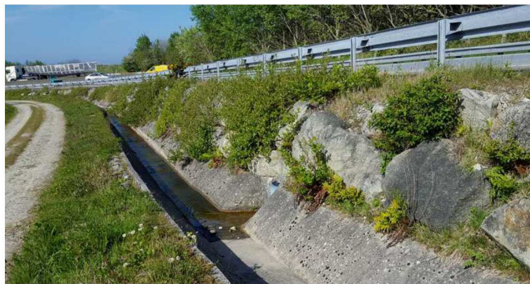
Enrochement avec végétation saxicole sur les bernes de la déviation
