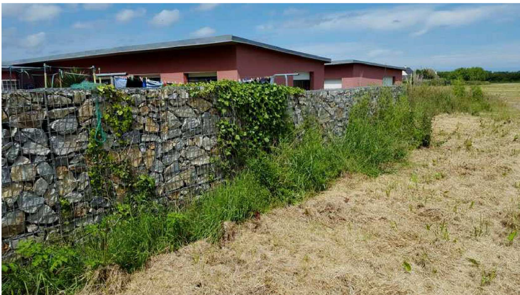
Vue sur un muret de gabion récent
