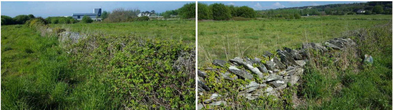
Aperçu des vieux murets
