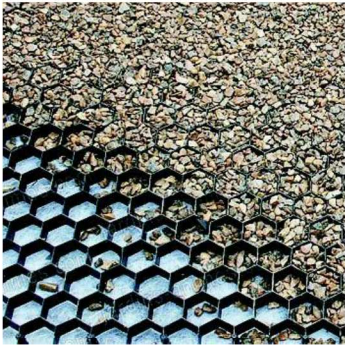
Structure en nid d'abeille remplie de graviers
