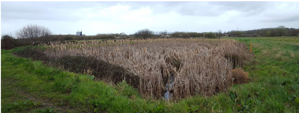
Aperçu du bassin en Mars 2021
