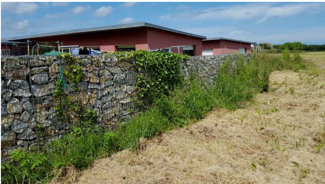
Vue sur un muret de gabion récent
