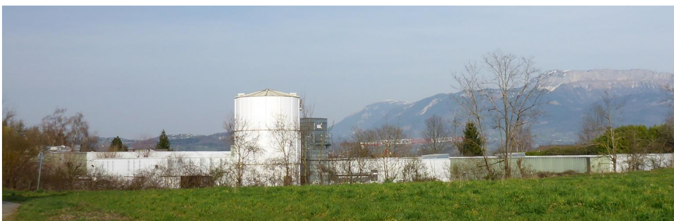
Figure 59 : Le bâtiment industriel et l'émergence de son silo marque l'ambiance paysagère au Nord de la parcelle ©cvp
