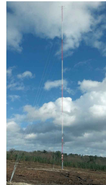
Illustration 22: Exemple d'un mât de mesure de 100 m sur un site d'étude
