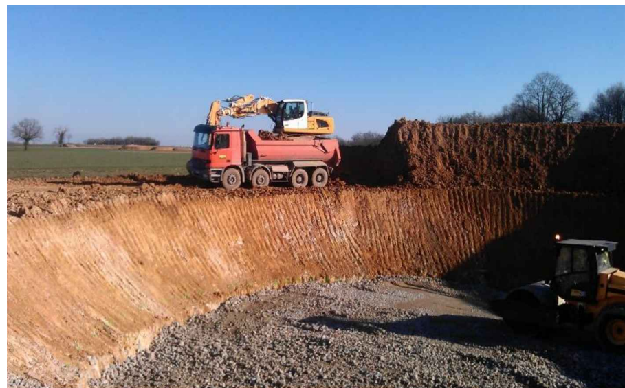
Illustration 139: Travaux pour une fondation
