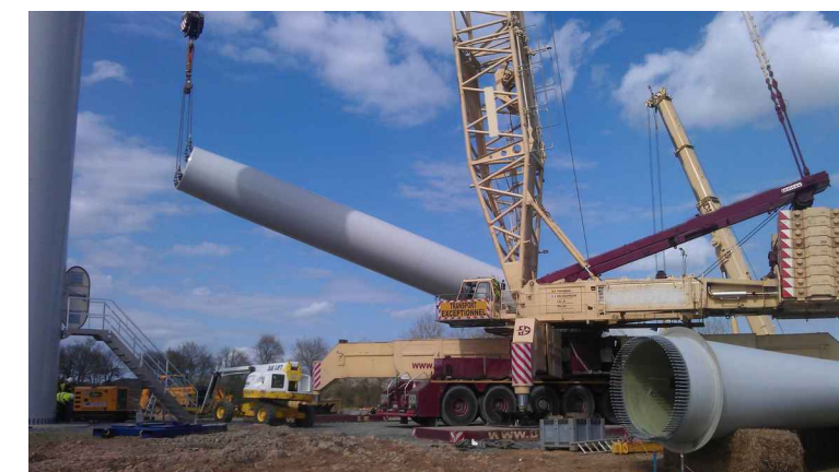
Illustration 151: Grue de levage sur une plateforme
