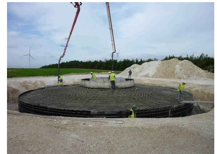
Illustration 149: Construction d'une fondation
