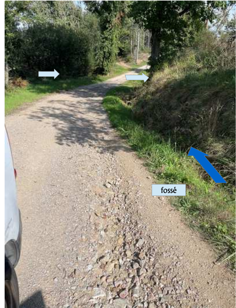
Photo N° 3 Vue du fossé le long du chemin
