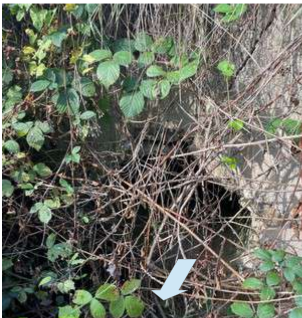
Vue du détonnement de la buse en DN 800 mm avant débroussaillage
