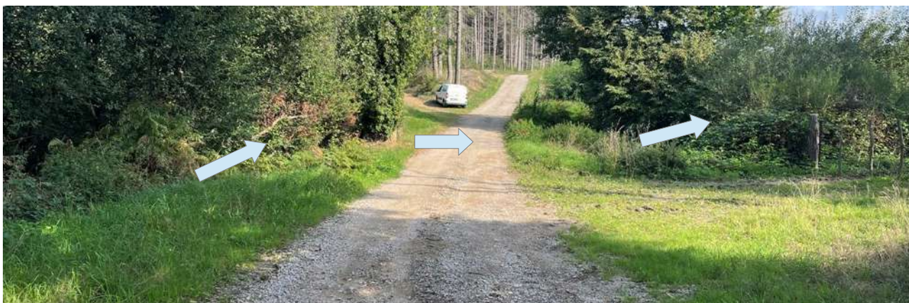
Passage du ruisseau sous le chemin forestier
