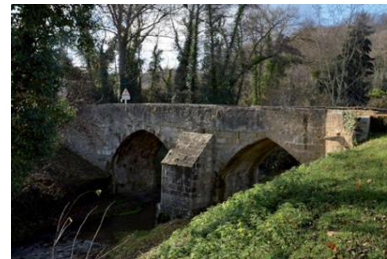
Photographie 126 – Pont sur le Gaduet (Source : ENCIS ENVIRONNEMENT)
