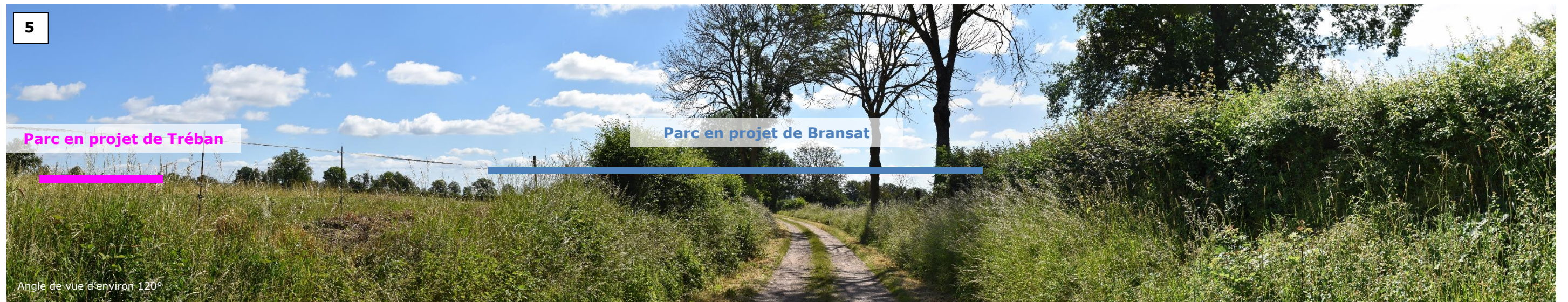
Photographie 161 – Vue panoramique orientée est depuis la limite bâtie est du hameau des Bagnolets, sur un chemin, et emprise théorique des parcs éoliens en projet et/ou existants (Source : ECO-STRATEGIE, juin 2022) – localisation point 5 Figure 116 page 198
