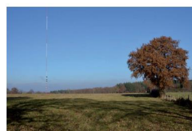
Mât de mesure du vent et chêne isolé en limite de parcelle
