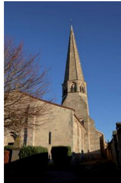
Photographie 119 – Eglise de Laféline (Source : ENCIS ENVIRONNEMENT)
