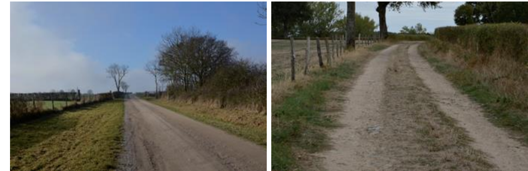
Photographie 168 - Chemins existants utilisés comme pistes d'accès (ENCIS)
