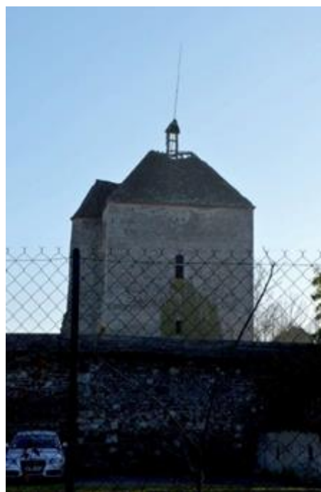
Photographie 123 – Donjon de Chenillat (Source : ENCIS ENVIRONNEMENT)
