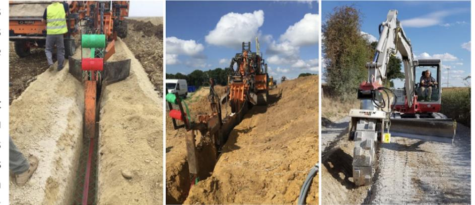
Photographies d'illustration de travaux de réalisation d'une tranchée en bord de route (Source : ELEC-ENR)
