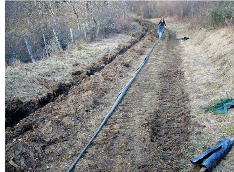
Creusement du sillon et déroulement de la bâche
