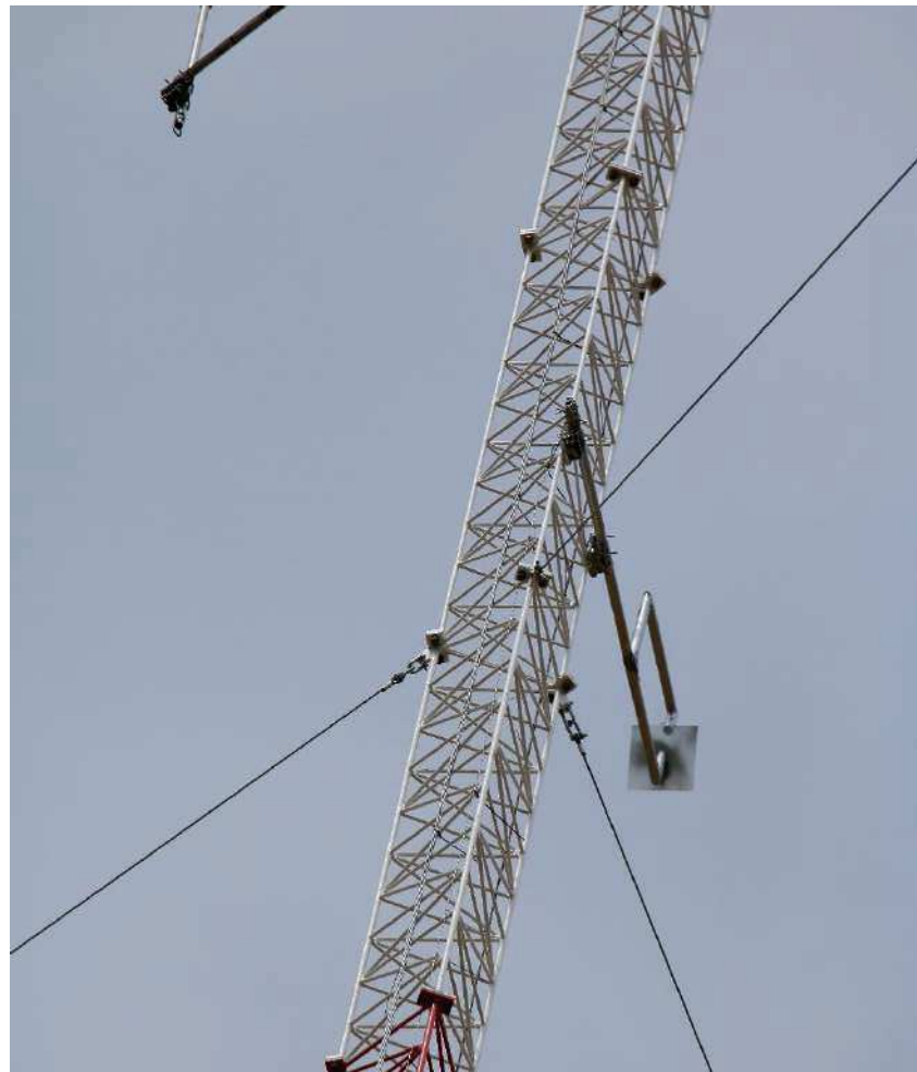
Photographie 8. Emplacement du micro sur le mât
