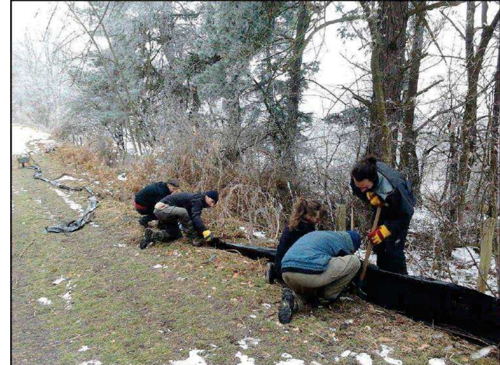
Mise en place des piquets et de la bâche à l'avancement
