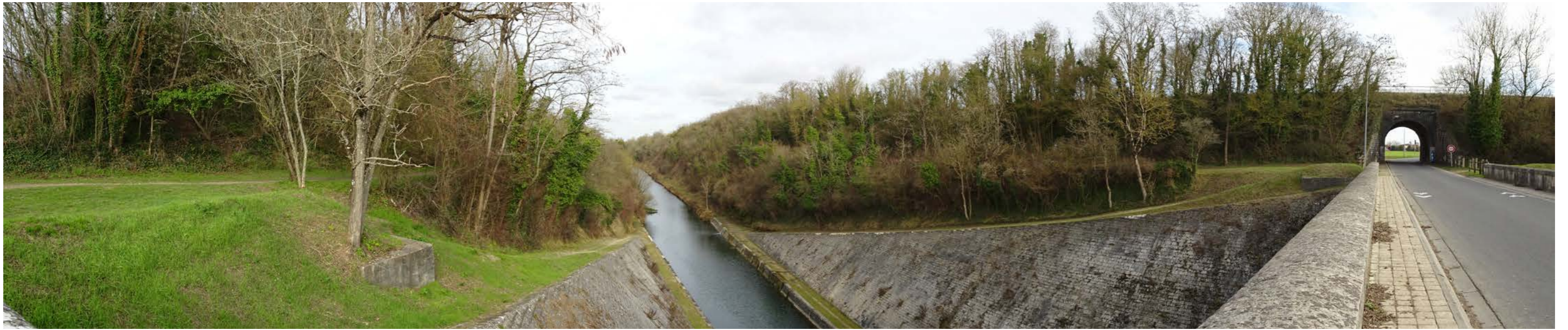
Photo 141 : Illustration du réseau hydraulique construit fin 19ème : le canal de Marans à la La Rochelle ; les vues sont fermées par le relief encaissé du canal et la masse arborée le long des rives en direction du projet, ici vue entre Dompierre-sur-Mer et Belle-Croix
