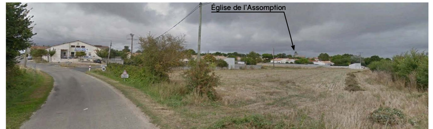
Photo 134 : Vue tronquée par la trame bâtie et végétale depuis la D110 en direction du projet.
