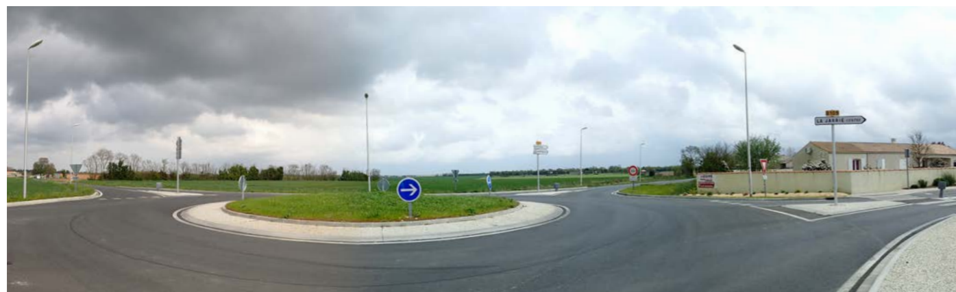
Photo 174 : Vue ouverte depuis les abords de la RD 109 en sortie de bourg de la Jarrie
