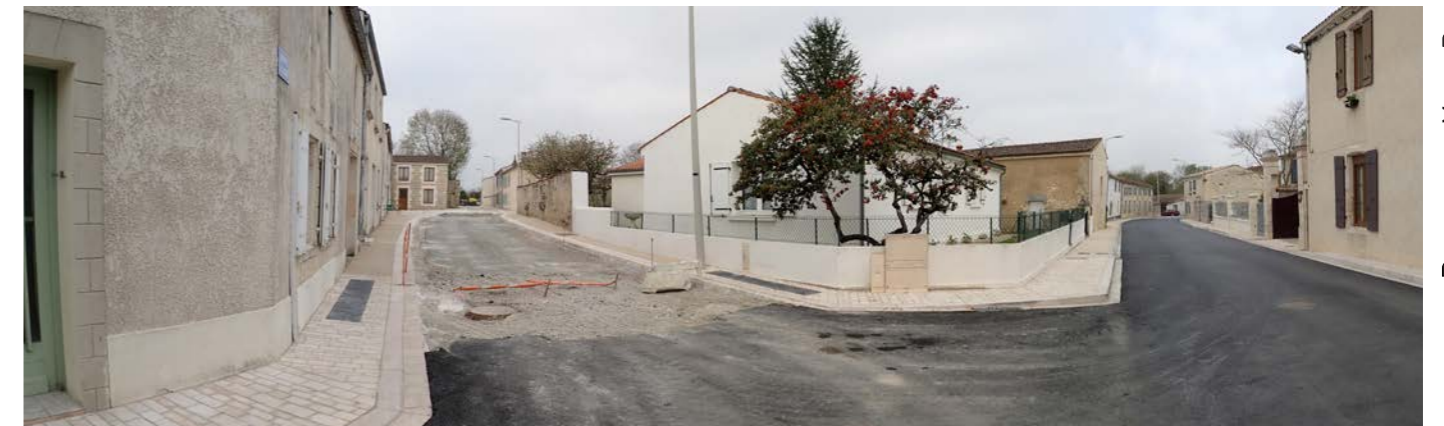
Photo 170 : Depuis le centre-bourg de Saint-Christophe, les vues sont majoritairement masquées par la trame bâtie
