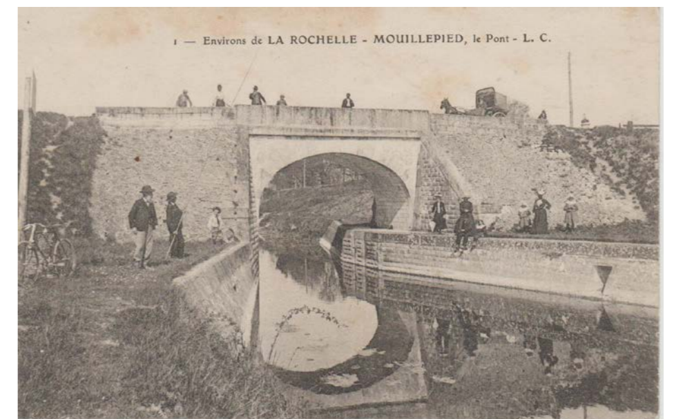
Photo 139 : Carte postale du pont de Mouillepieu et du canal de Marans
