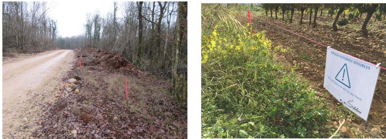
Balisage temporaire en phase chantier © Siteléco
