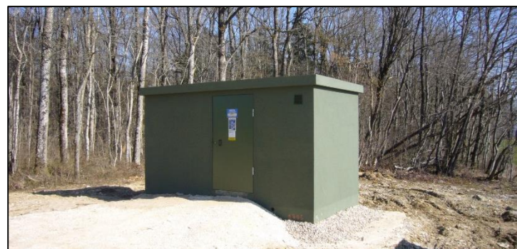
Photo 60 : Référence d'un enduit vert feuillage pour un poste de livraison (Source : BE Jacquel et Chatillon)
