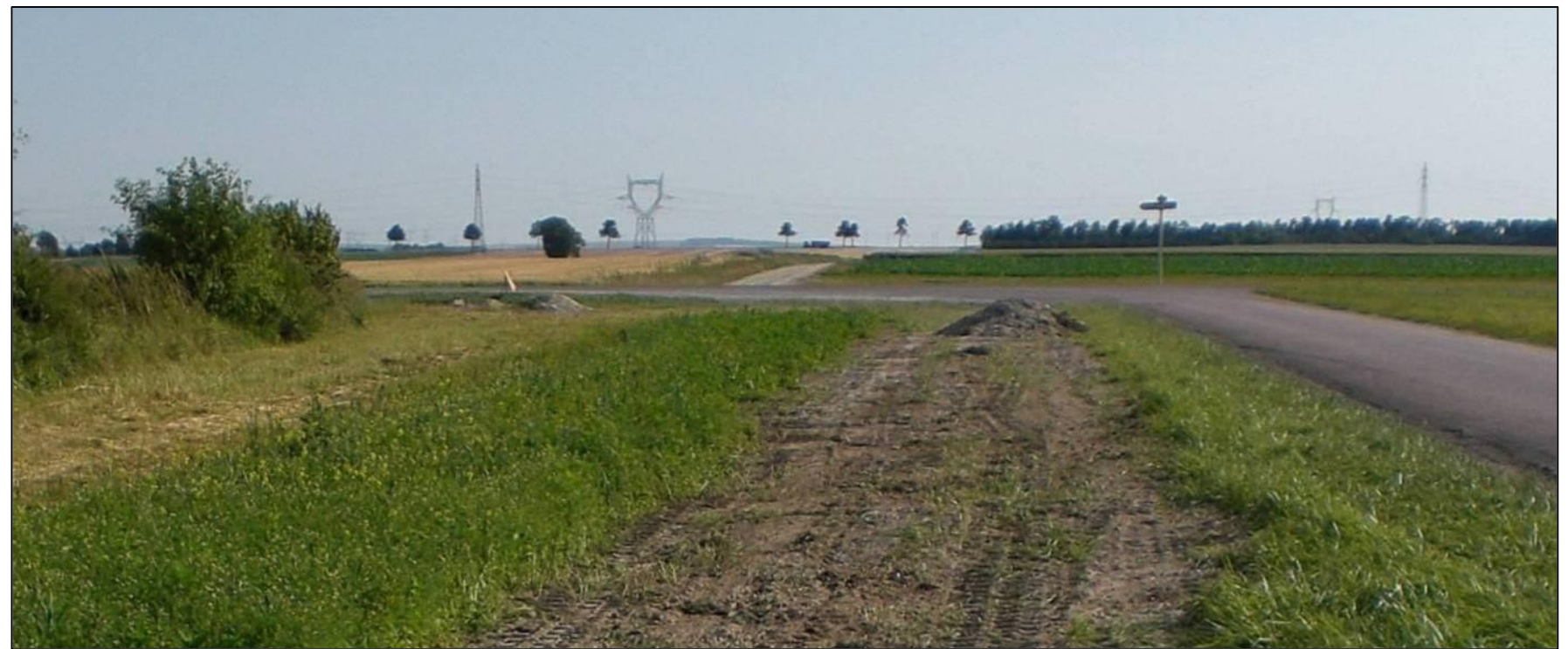
Photo 61 : Rebouchage de tranchée après passage des câbles électriques (Source : BE Jacquel et Chatillon)
