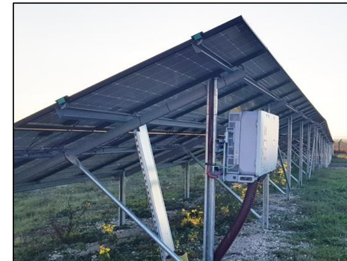
Photo 49 : Onduleur fixé à l'arrière des tables (Source : BE Jacquél et Chatillon)
