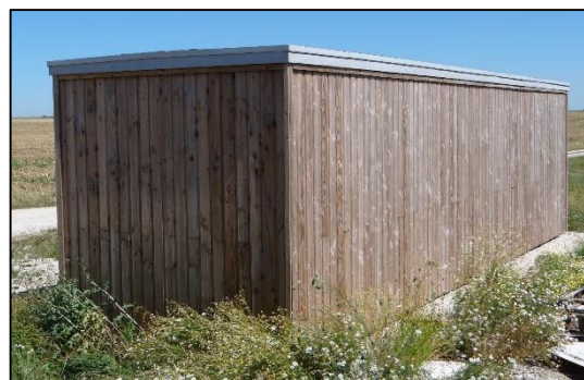
Photo 59 : Référence d'un bardage bois vertical pour un poste de livraison (Source : BE Jacquel et Chatillon)
