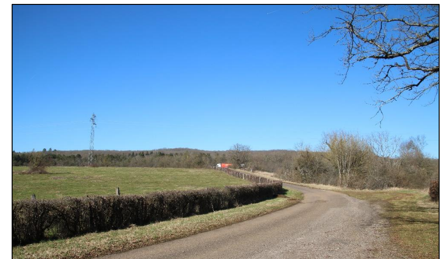
Photo 31 : Pylône et ligne haute tension depuis la marge Ouest de la ZIP (Source : BE Jacquiel et Chatillon)
