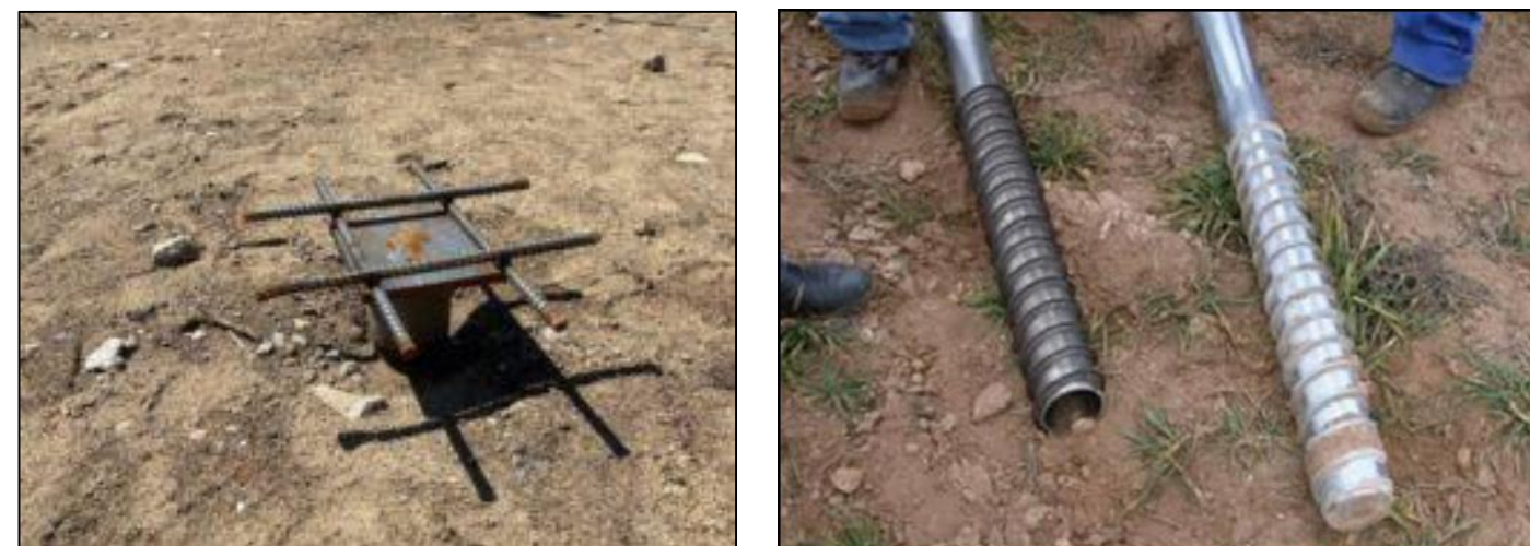
Photo 47 : Exemples de pieux battus à gauche et pieux vissés à droite (Source : Lesage excavation)
