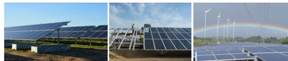
Photo 1 : Illustration de centrales photovoltaïque au sol (Source : TOTALENERGIES)
