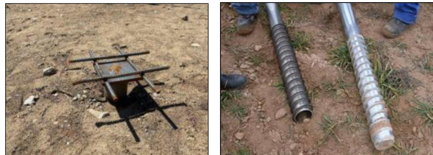
Photo 50 : Exemples de pieux battus à gauche et pieux vissés à droite (Source : Lesage excavation)
