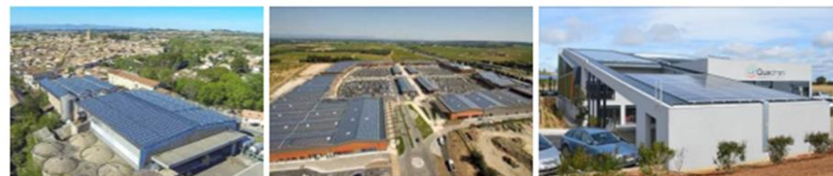
Photo 2 : Illustration de centrales photovoltaïque sur toiture (Source : TOTALENERGIES)
