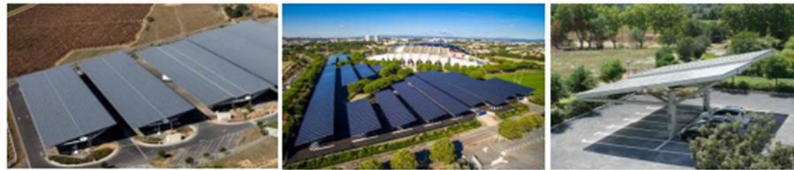
Photo 3 : Illustration d'ombrières photovoltaïques (Source : TOTALENERGIES)
