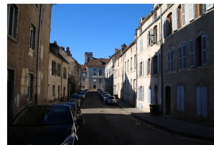
Photo 41 : Rue du palais, dans le Site inscrit des Quartiers Anciens de Vesoul (Source : BE Jacquel et Chatillon)
