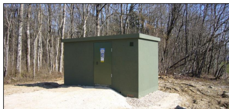
Photo 65 : Référence d'un enduit vert feuillage pour un poste de livraison (Source : BE Jacquel et Chatillon)
