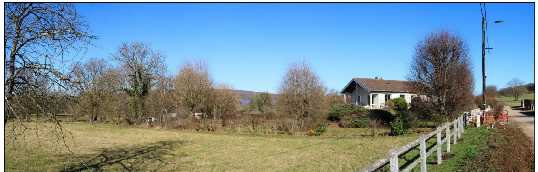
Photo 55 : Photomontage du projet depuis le point de vue n°6, au niveau de la zone pavillonnaire implantée à l'Est de Colombe-lès-Vesoul (Source : BE Jacquel et Chatillon)
