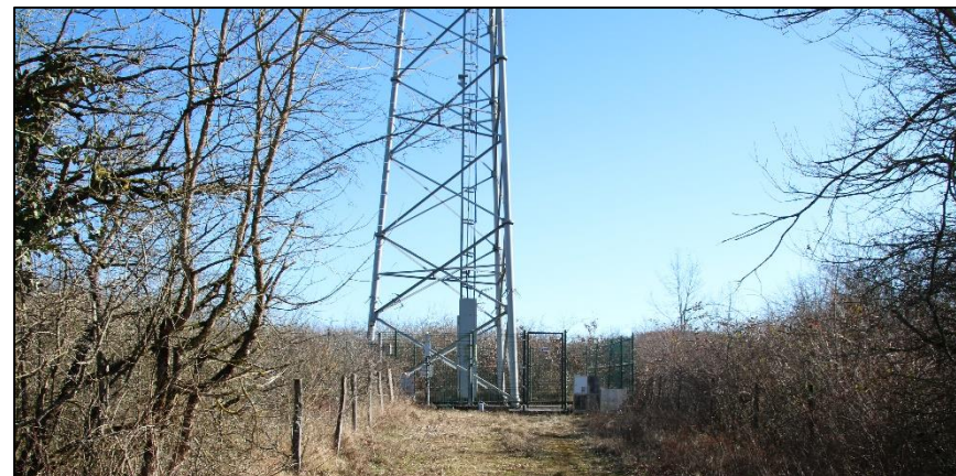
Photo 27 : Vue frontale sur la base de l'antenne depuis le contour Ouest de la ZIP (Source : BE Jacquiel et Chatillon)
