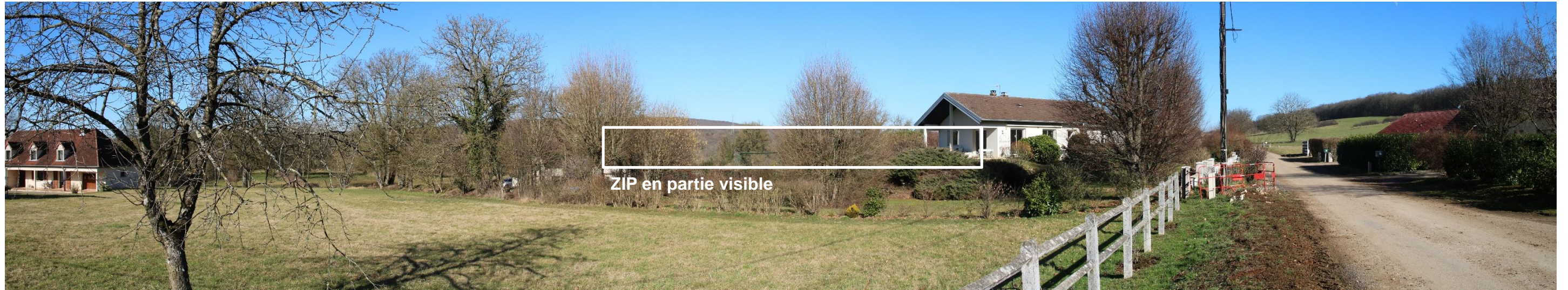
Photo 19 : Vue en direction de la ZIP depuis le quartier d'habitation situé à l'Est de Colombe-lès-Vesoul, angle de 180° (Source : BE Jacquel et Chatillon)
