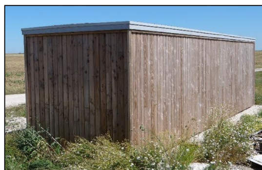
Photo 64 : Référence d'un bardage bois vertical pour un poste de livraison (Source : BE Jacquel et Chatillon)
