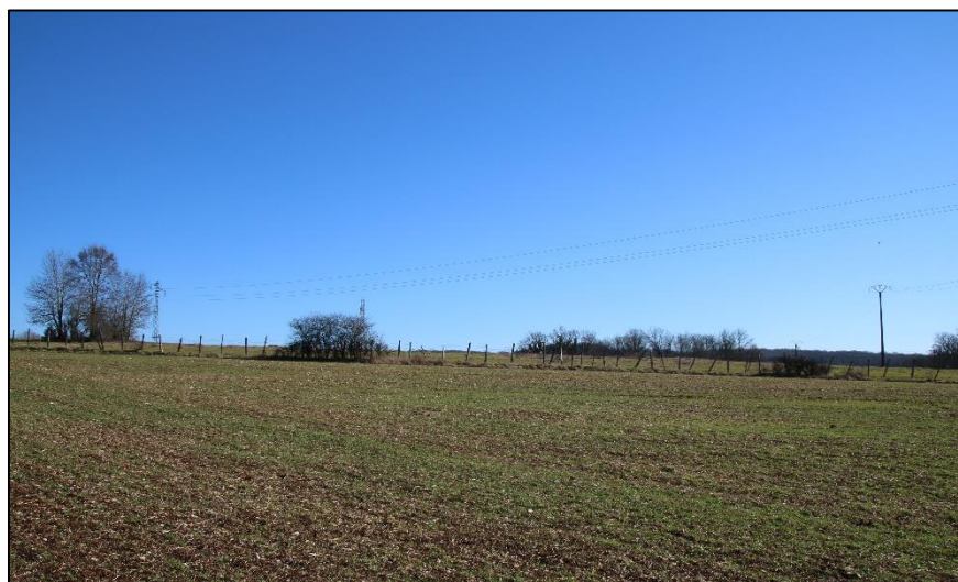
Photo 29 : Antenne téléphonique, lignes électriques haute tension et basse tension depuis le N19 (Source : BE Jacquiel et Chatillon)
