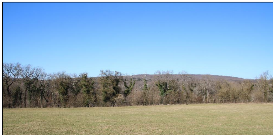
Photo 26 : Antenne depuis le hangar agricole, en marge de Colombe-lès-Vesoul (Source : BE Jacquiel et Chatillon)
