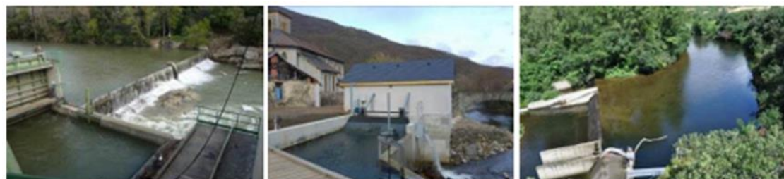
Photo 5 : Illustration de centrales hydroélectriques (Source : TOTALENERGIES)
