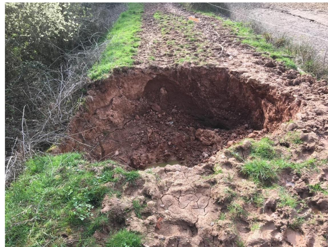
Figure 3 : Photo C - Visuel de la digue d'étang à traverser pour l'accès à la parcelle n° AT 139 (digue détériorée par l'érosion, réparée depuis mais fragile) (source : M. Kronenberg, 2023)
