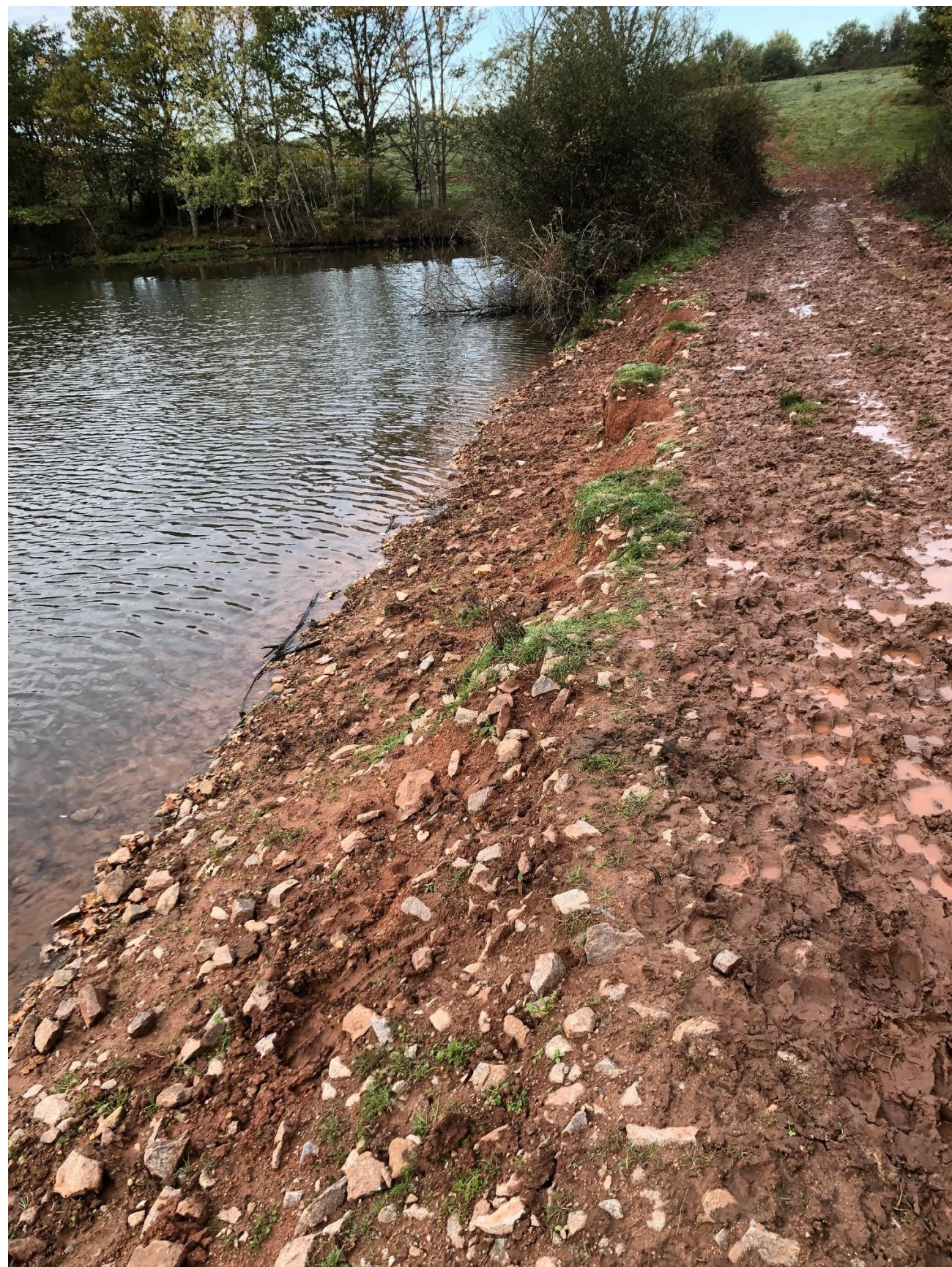
Figure 1 : Photo A - Visuel de la digue d'étang à traverser pour l'accès à la parcelle n°AH93 (photo prise l'hiver avec défoncement de la digue par le piétinement des vaches) (source : M. Kronenberg, 2023)
