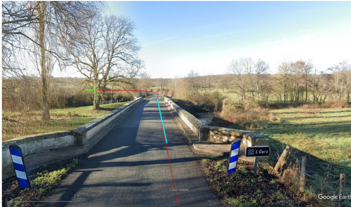
Figure 3 : Passage d'ouvrage sur cours d'eau (sources : SOLVEO ENERGIES, Google Earth, 2024)
