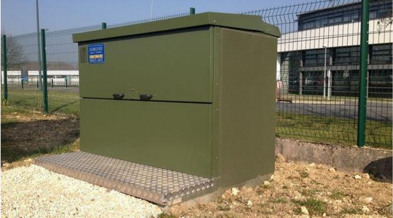
Figure 6 : Exemple d'armoire de coupure
