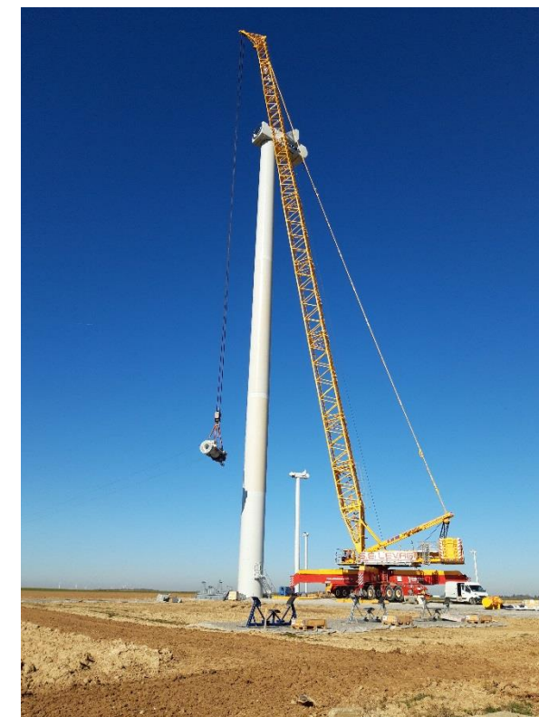
Figure 64 : Montage de la génératrice (Source : VOLKSWIND)
