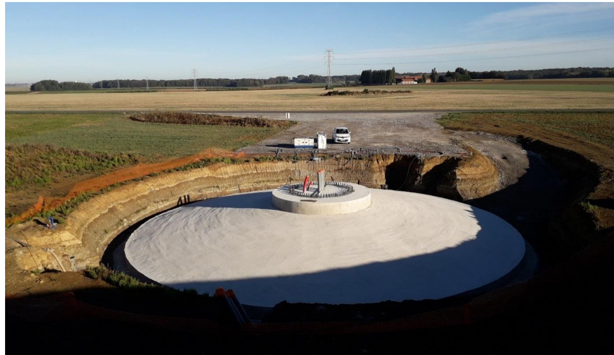
Figure 56 : Fondation après coulage béton
