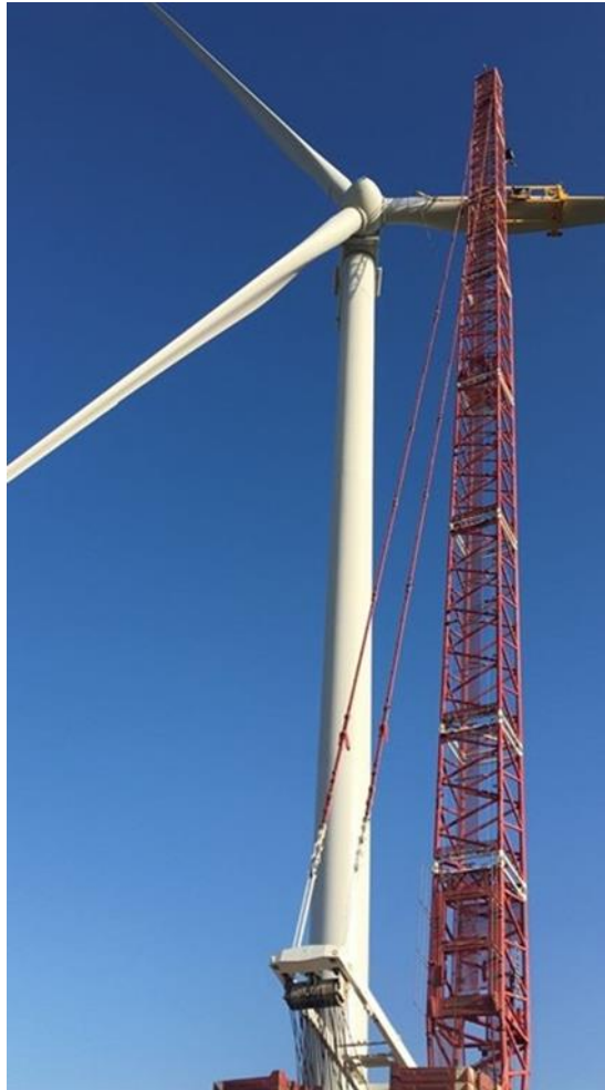
Figure 65 : Montage des pales (Source : VOLKSWIND)
