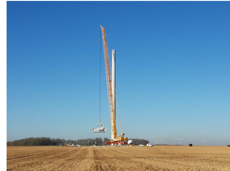
Figure 63 : Montage de la nacelle (Source : VOLKSWIND)
