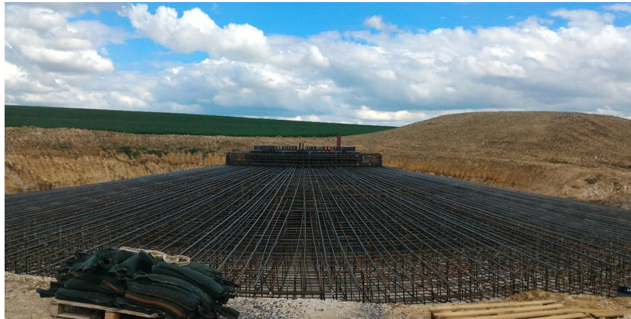
Figure 55 : Ferrailage du massif
