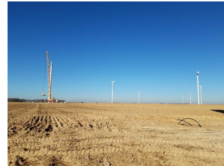
Figure 66 : Un parc de neuf éoliennes Vestas V112 en construction (Source : VOLKSWIND)
