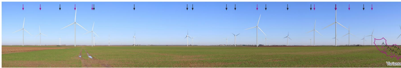
Point de vue A: vue depuis la RD 153 entre Jonville et le Moulin de Jonville
