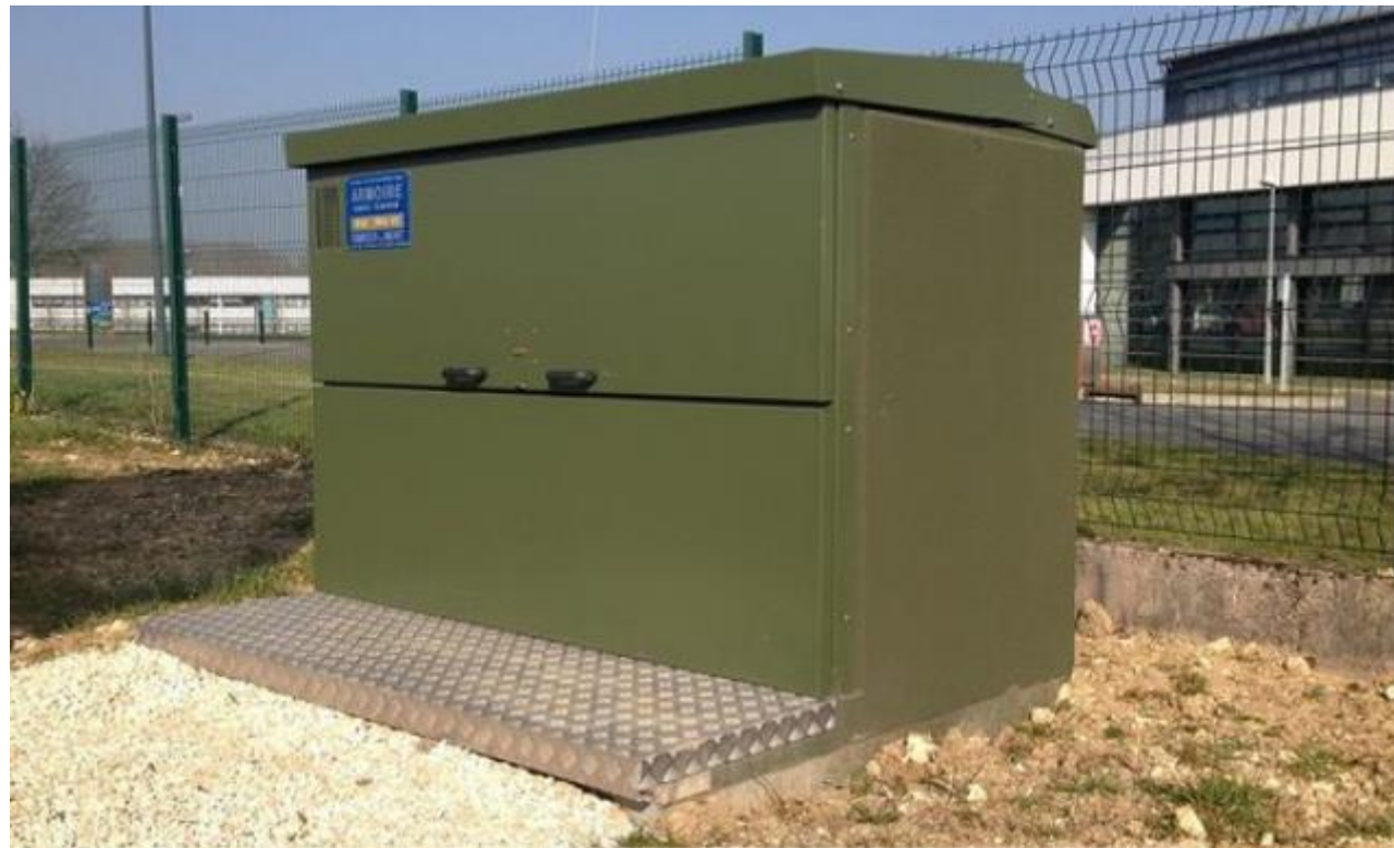
Figure 51 : Exemple d'armoire de coupure
