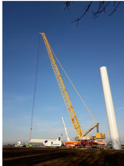
Figure 57 : Grue permettant l'assemblage des différents éléments d'une éolienne
