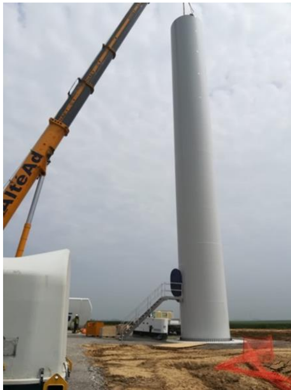
Figure 61 : Montage de la première section du mât (Source : VOLKSWIND)
