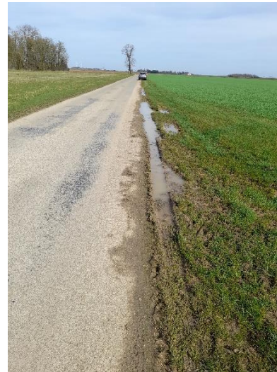
Figure 7 : Accotement de la RD 154 (repère E à F), source : Volkswind :
