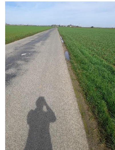
Figure 8 : Accotement de la RD 154 (repère E à F, source : Volkswind)
