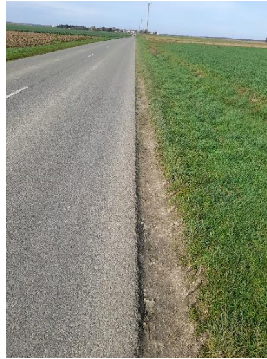
Figure 4 : Accotement de la RD 935 (repère C à D, source : Volkswind)
