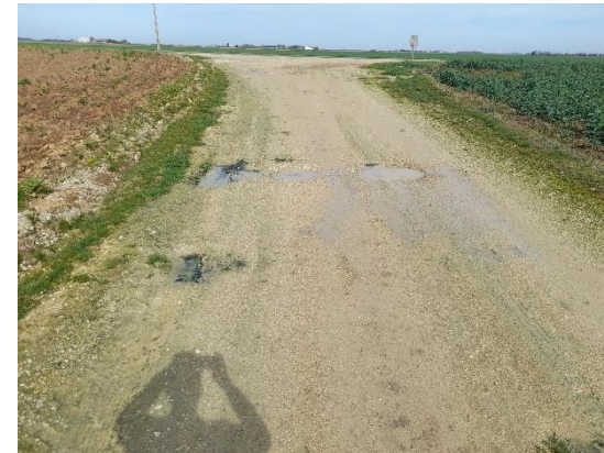
Figure 2 : Chemin rural aménagé pour le parc éolien du Canton de Bonneval (repères A et B à C, source : Volkswind)
