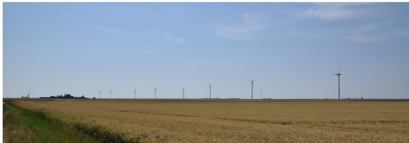
Fig. 47 : Parc éolien du canton de Bonneval
