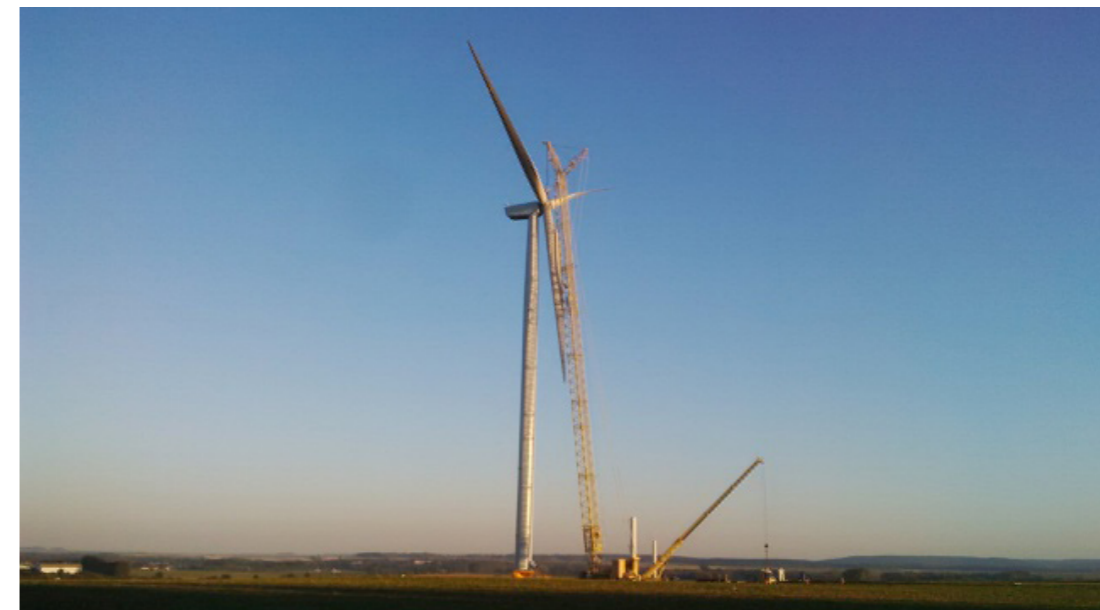
Fig.224 : Assemblage d'une éolienne
