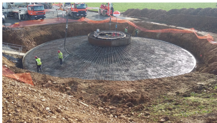
Fig. 221 : Mise en place d'une fondation
