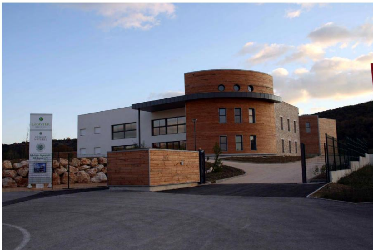
Figure 11. Vue façade nord
