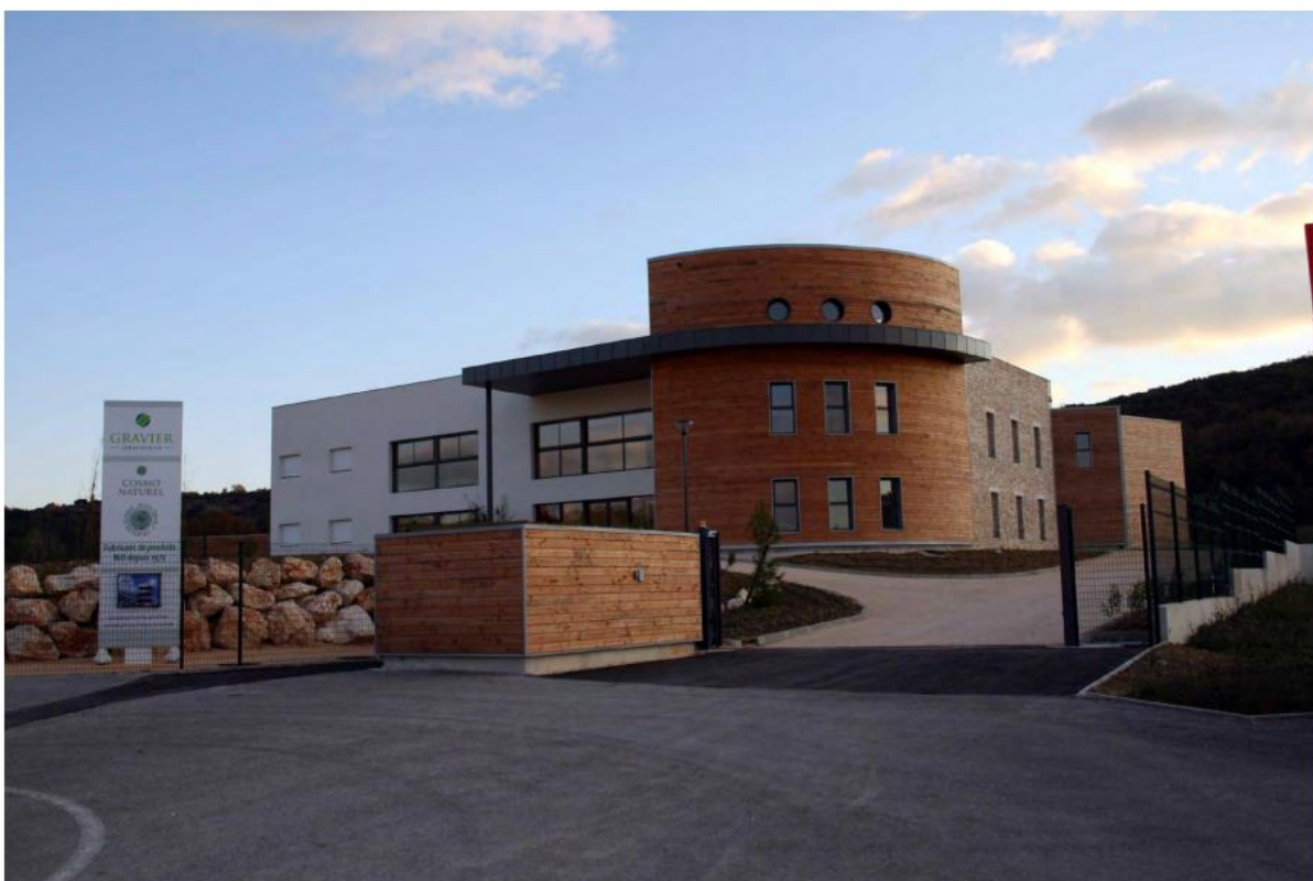
Figure 8. Vue façade nord
