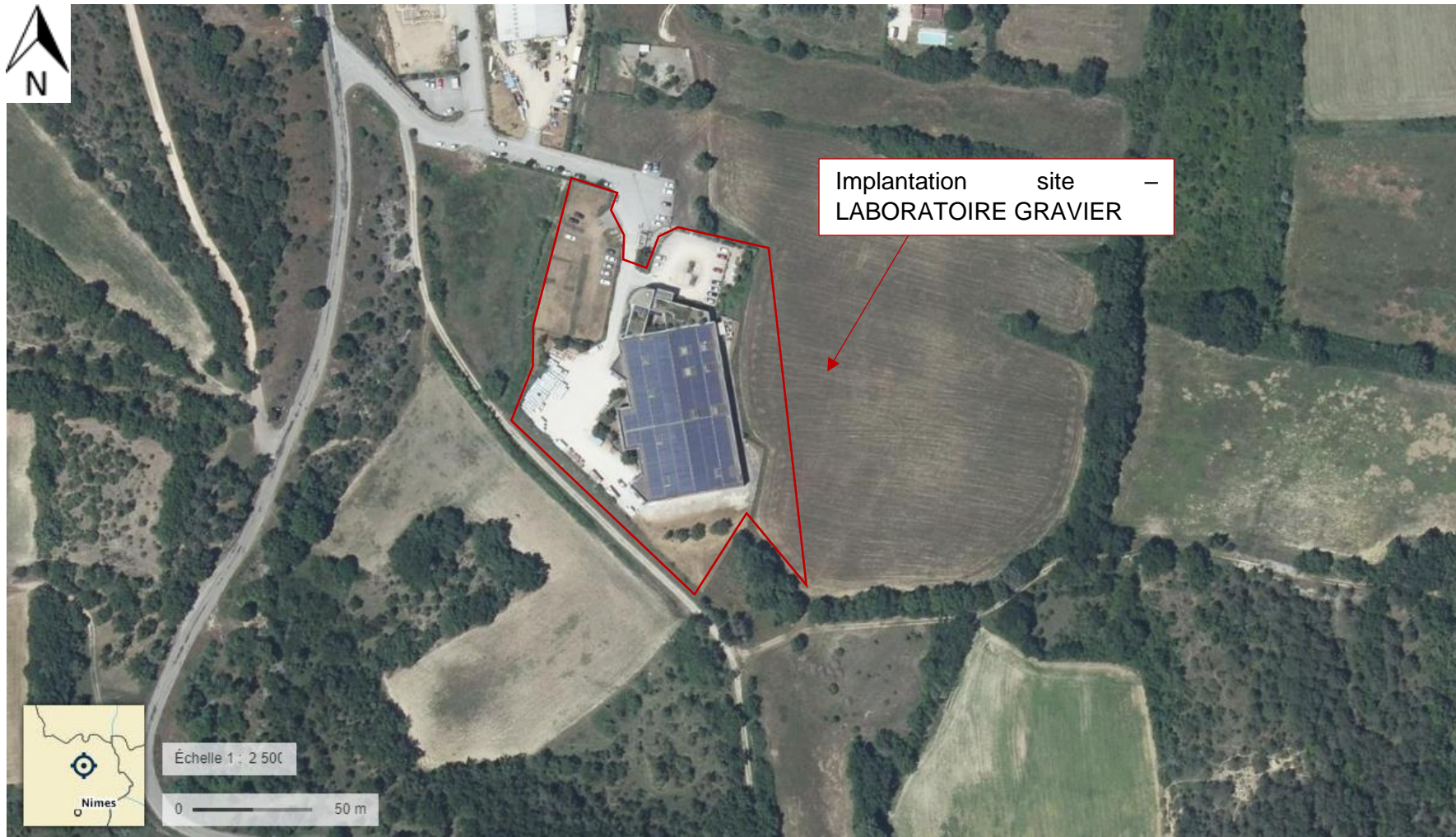
Figure 2. Situation générale - échelle : 1/2 500 (échelle modifiée) - source : Géoportail (cliché avant sinistre)
