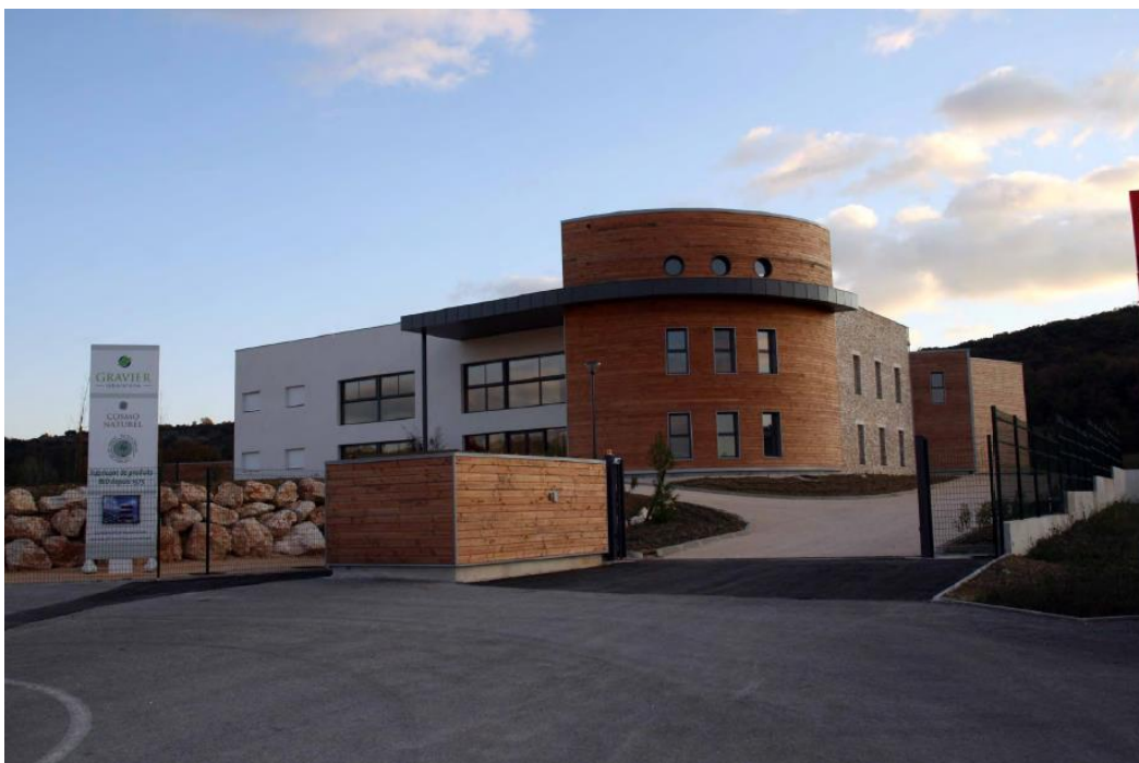
Figure 66. Façades Nord / Nord-Est
