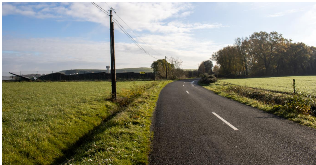
Photo 15. Route communale au droit de la partie Sud de la ZIP
