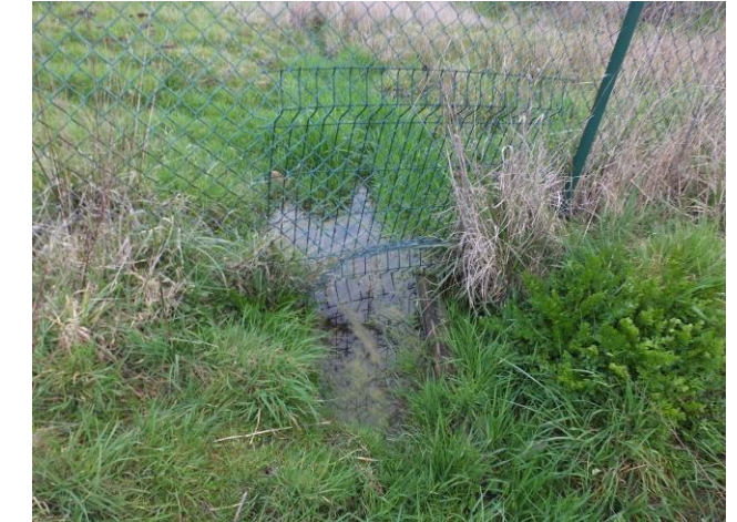
Photo 5. Entrée nord du fossé en eau qui traverse l'AEFF
