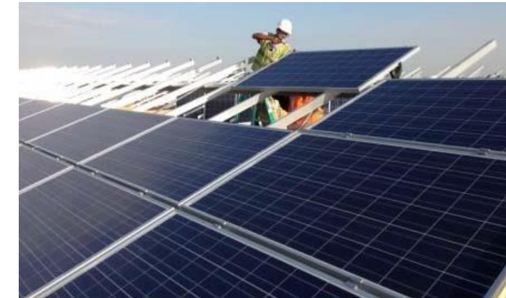
Photo 34. Exemple de mise en place des panneaux sur les structures
