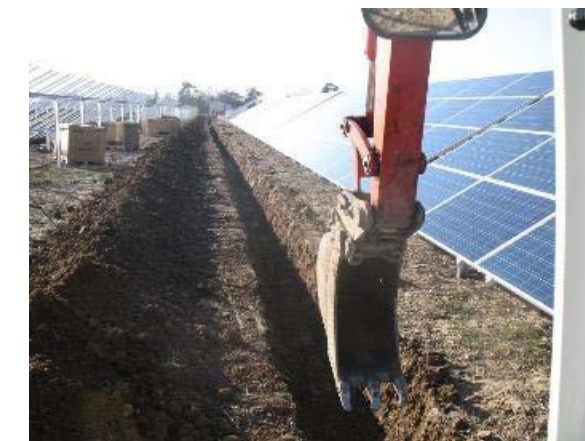
Photo 35. Exemple de tranchée entre deux tables photovoltaïques
