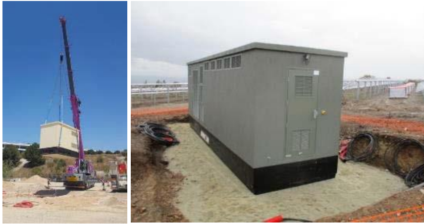
Photo 36. Installation d'un poste électrique
