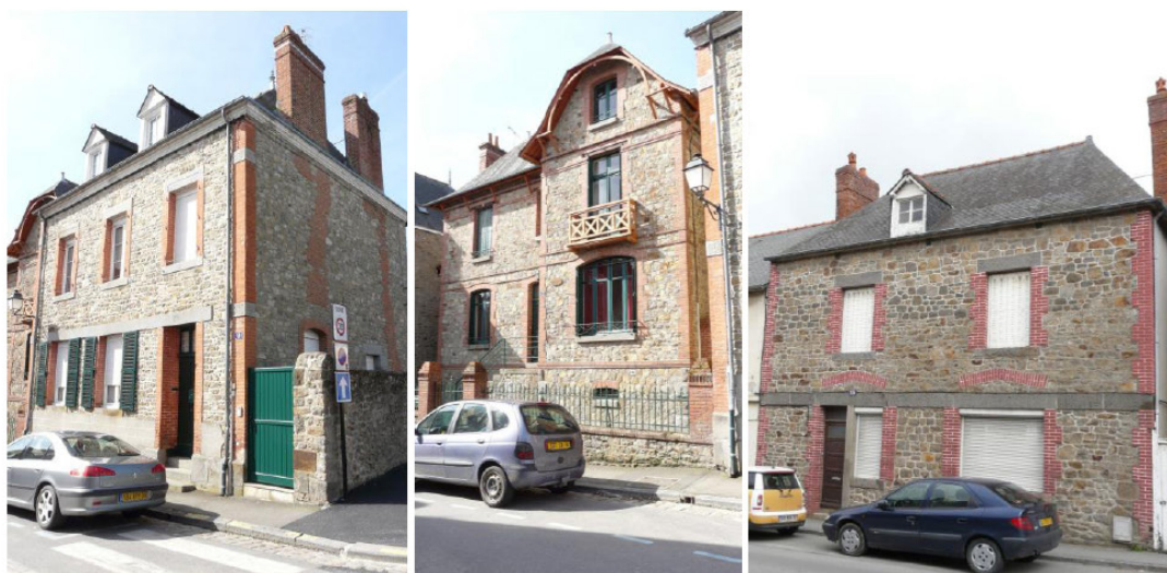
FACADES AVEC DECORS EN BRIQUES
