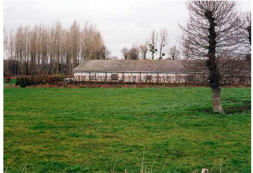
Haie linéaire le long d'un bâtiment agricole : renforce la présence du bâtiment plutôt que le masquer.
