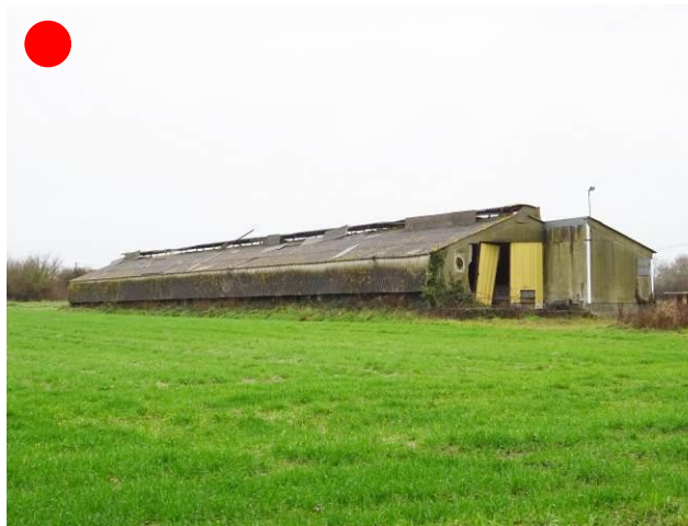
Bâtiment agricole abandonné donnant un caractère automatiquement dégradé à la frange
