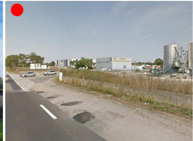
Frange "dégradée" : présence de pré-enseigne en entrée de zone, accotements abimés et clôtures dégradées
