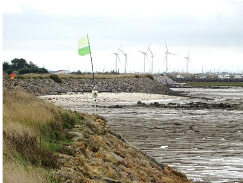
Vue sur la digue en enrochements séparant l'océan des marais, et à l'arrière-plan sur le parc éolien de Bouin - Pointe des Poloux, Bouin
