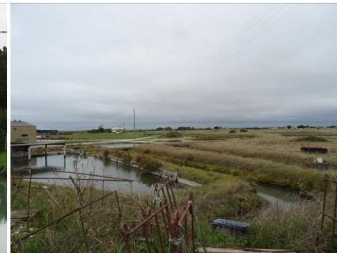
Claires à huîtres - Côté Nord du port des Brochets, Bouin
