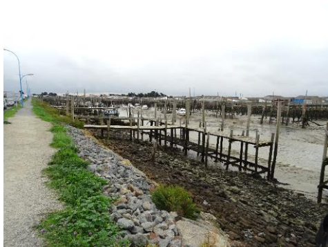
Site inscrit du port du Bec et ses nombreux pontons en bois
