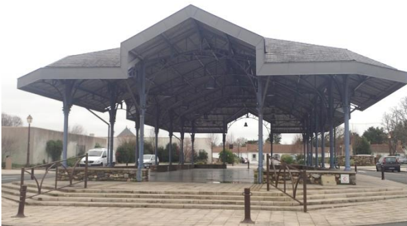
La halle à Beauvoir-sur-Mer
