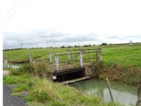
Passerelle permettant le passage au-dessus d'un canal - La Chevoirie, Bouin
