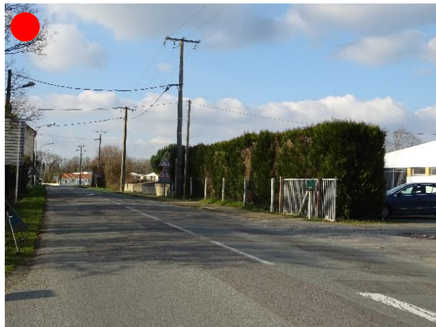
Entrée de ville "dégradée" en raison de la présence d'une haie de thuyas, de clôtures non qualitatives et d'un mur non enduit à l'arrière-plan
