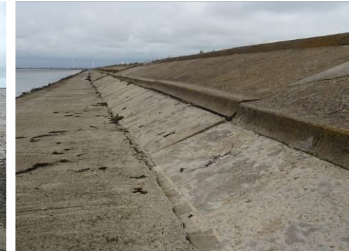
Digue en béton entre l'océan et le polder du Dain ; à l'arrière-plan, vue sur le parc éolien de Bouin
