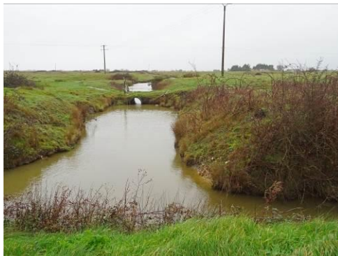
Canal et sa traversée aménagée pour le passage des bovins - Ouest de la Grande Ruelle, Saint-Gervais
