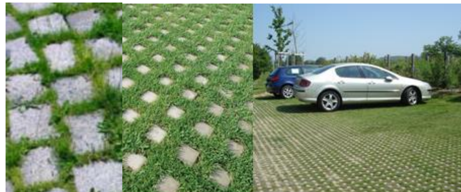
Exemple de traitement respectueux de l'environnement : pavés enherbés limitant la perméabilité des sols
