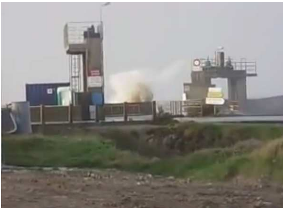
Figure 2-5 : extrait d'une vidéo amateur durant la tempête de mars 2008, extrémité Sud de la digue du Dain.
