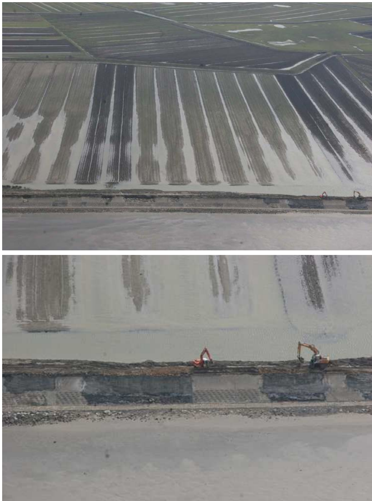
Figure 5-39 : photos aériennes obliques, digue de la Parisienne (photo : DREAL, 2 mars 2010).
