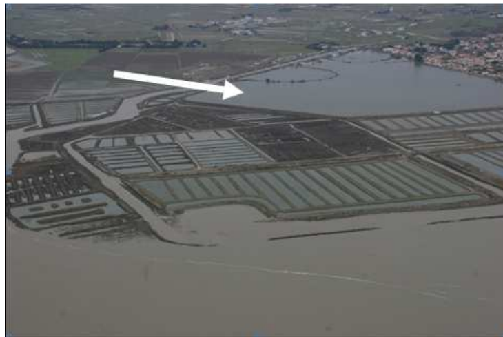
Figure 2-4 : photo aérienne oblique du polder des Rouches (en haut à droite) totalement inondé 3 jours après Xynthia (source : photo DREAL, 2 mars 2010).
