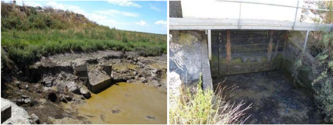
Figure 3-12 : Ouvrages traversants présents sur la digue de la Parisienne.
