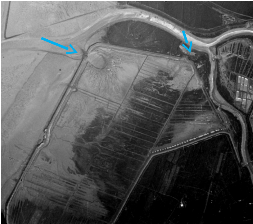
Figure 5-38 : digue de la prise, photo aérienne du 15 mai 1950 (source : Géoportail, IGN).
