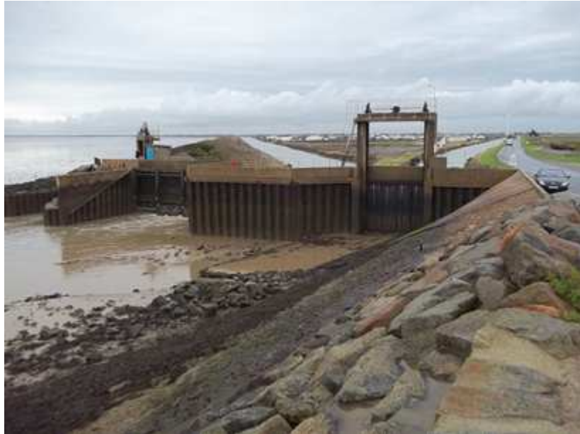
Figure 3-21 : vannages à jonction de la digue du Dain avec le port du Bec.
